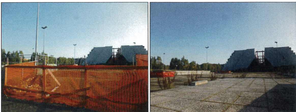
Vista frontale del parcheggio rialzato
