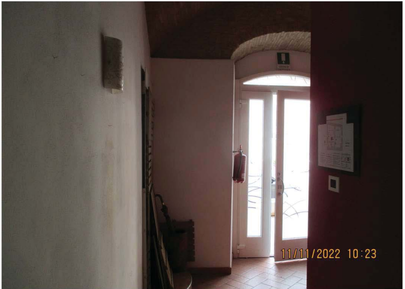
Foto n°7 - Disimpegno piaano terra
