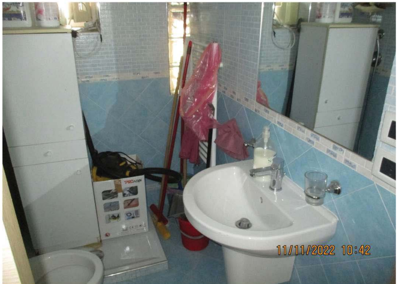
Foto n°10 - Bagno piano primo
