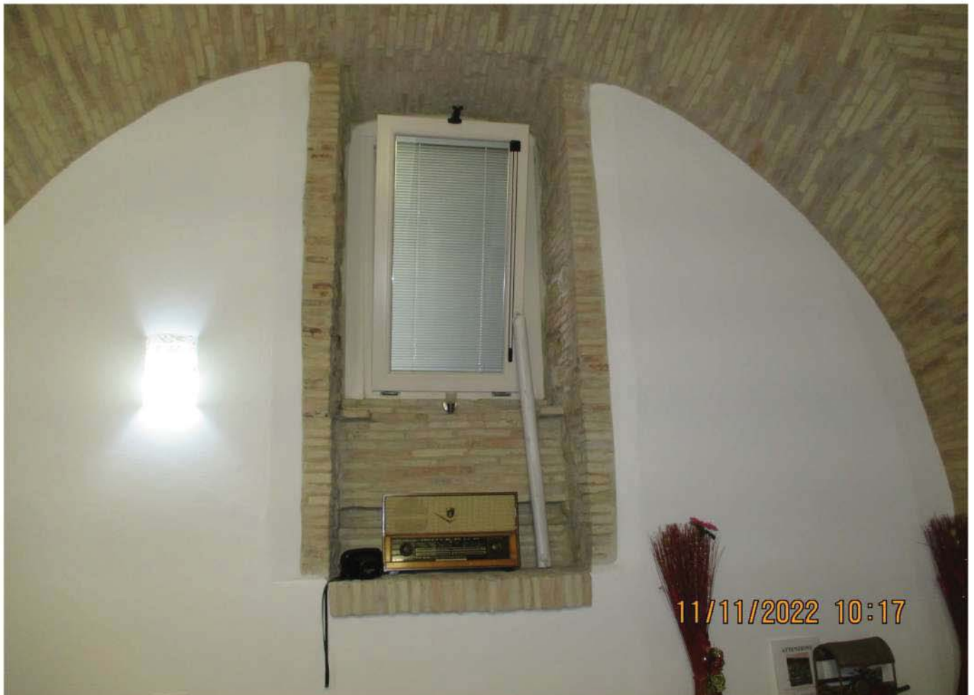
Foto n°6 - Ufficio piano terra
