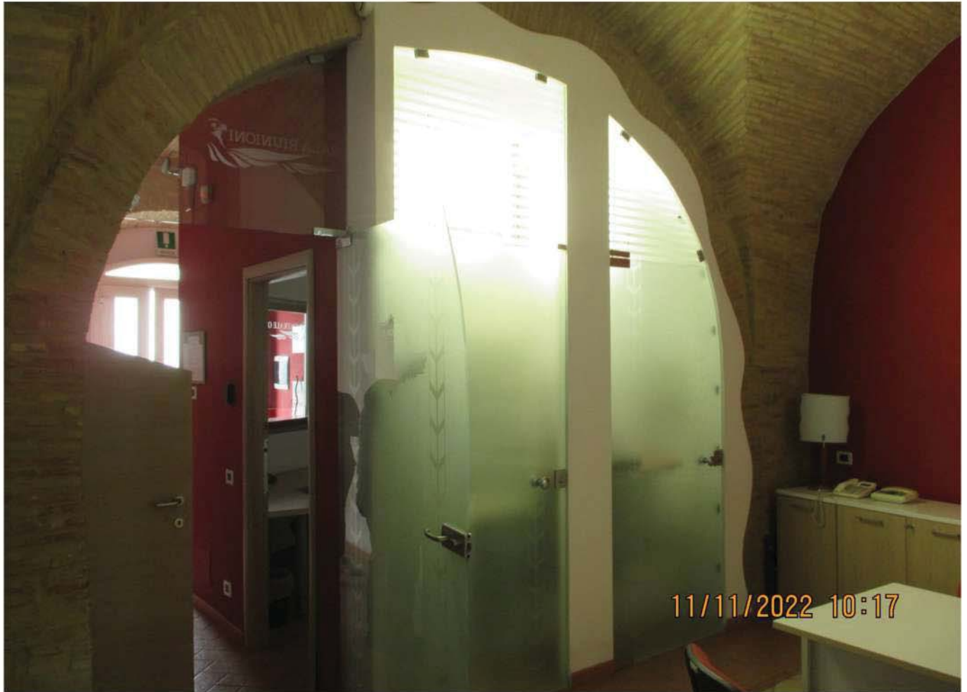
Foto n°5 - Ufficio piano terra
