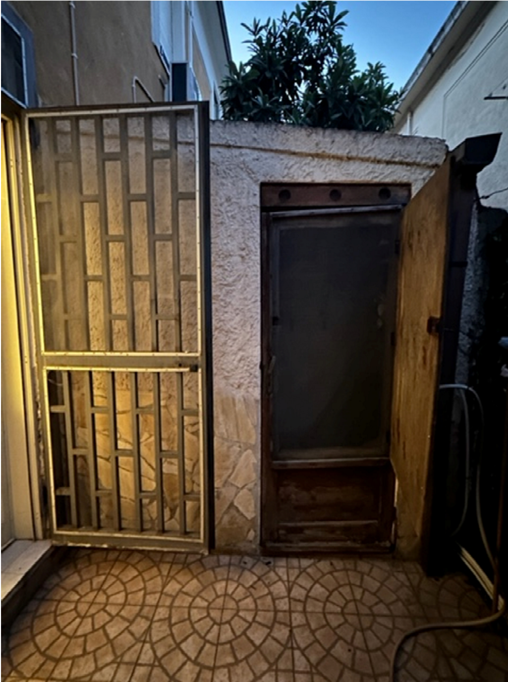
Foto nr.6 : particolare del vano abusivo realizzato nel cortile
