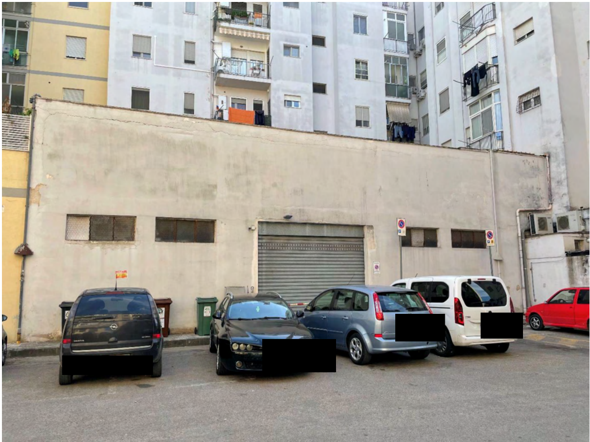
Foto n. 3: Vista del prospetto del locale artigianale dalla via Liguria.
