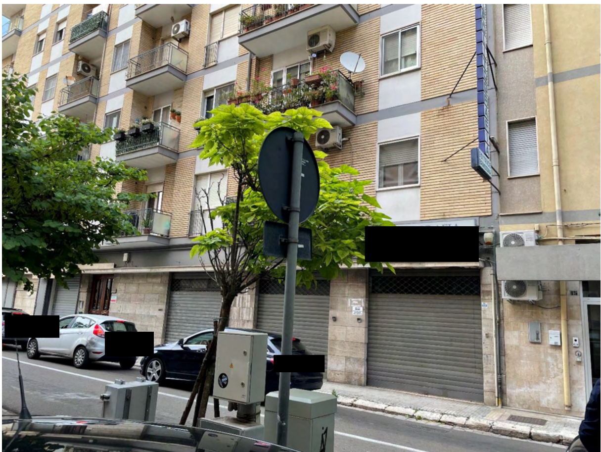
Foto n. 4: Vista del prospetto del locale artigianale dalla via Martiri delle Fosse Ardeatine.
