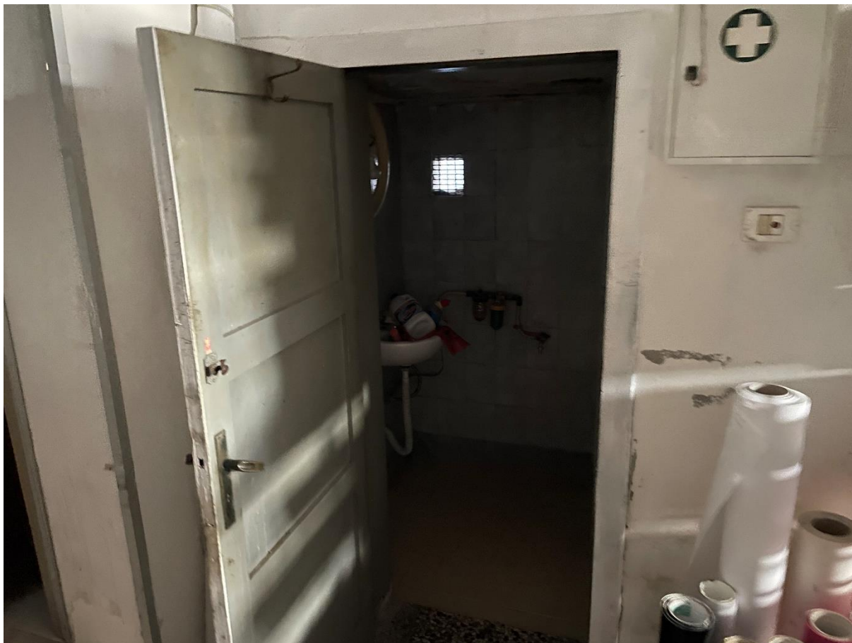
Foto n. 11: Vista esterna del bagno.
