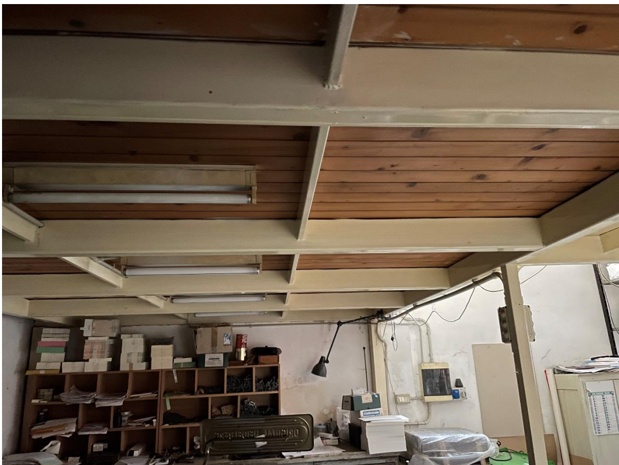
Foto n. 10: Vista ravvicinata della struttura del soppalco.
