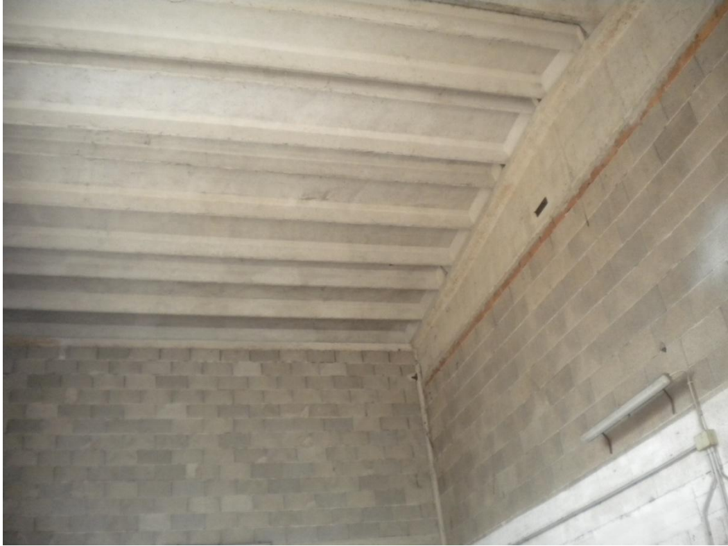
Particolare del solaio prefabbricato
