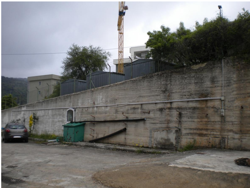
Muro di contenimento a confine
