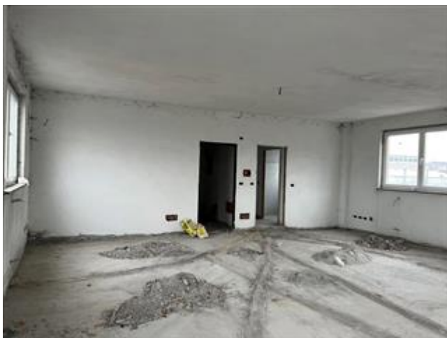
ZONA PREVISTA COME UFFICIO OPEN SPACE - allo stato da ultimare
