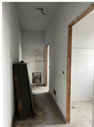
ZONA PREVISTA COME CORRIDOIO/DISIMPEGNO - allo stato da ultimare
