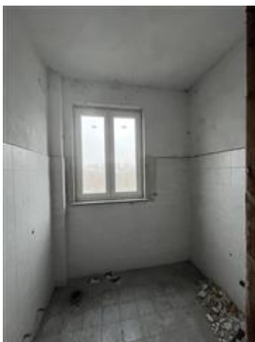
ZONA PREVISTA COME WC - allo stato da ultimare
