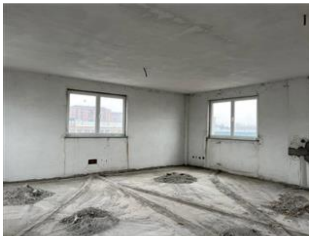
ZONA PREVISTA COME UFFICIO OPEN SPACE - allo stato da ultimare
