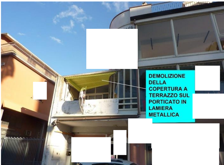
Evidenza della copertura del terrazzo da abbattere
