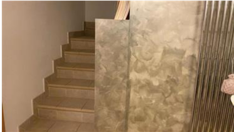
Scala interna in rivestita in gres porcellanato di collegamento P1-2
