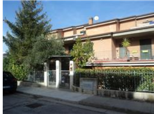
Accesso pedonale PT su via Silone n. 95
