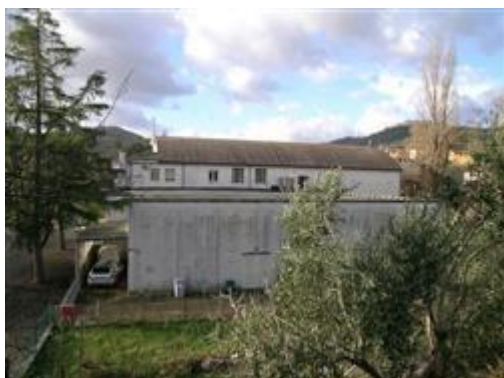
Vista panoramica del complesso
