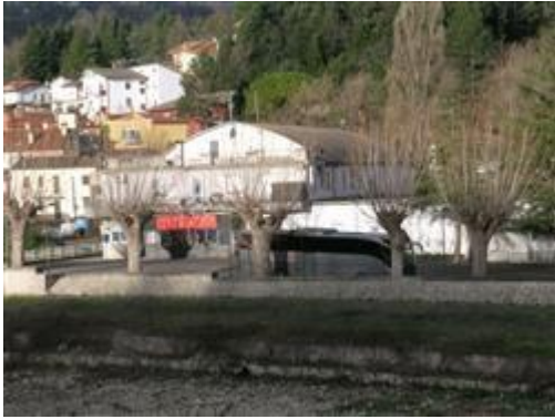
Vista panoramica del complesso
