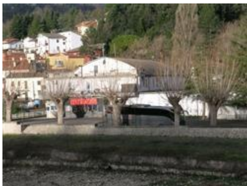
Vista panoramica del complesso
