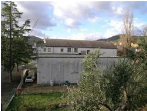
Vista panoramica del complesso
