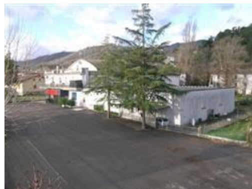
Vista panoramica del complesso
