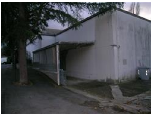
Tettoia non autorizzata da rimuovere
