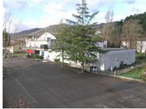
Vista panoramica del complesso
