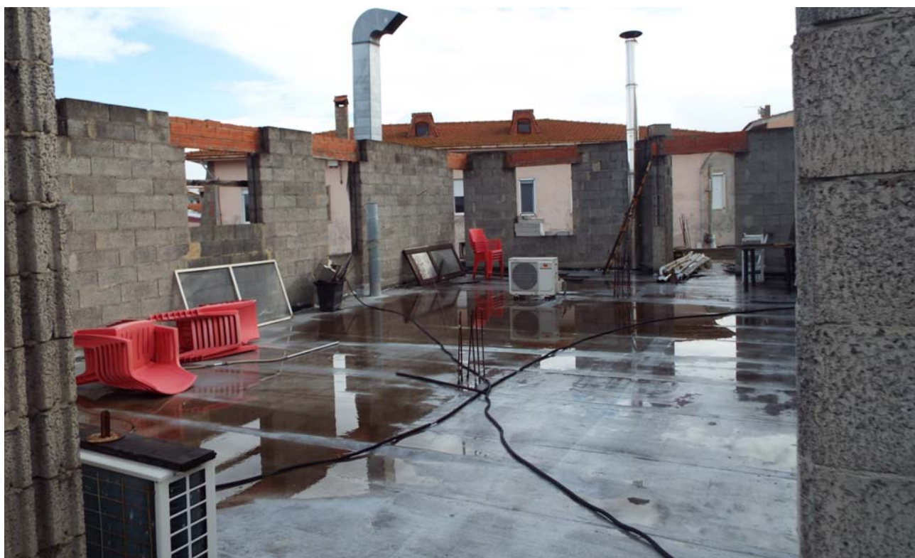
Lastrico solare e tamponature esterne sopraelevazione
