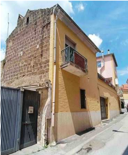
Prospetto sulla strada
