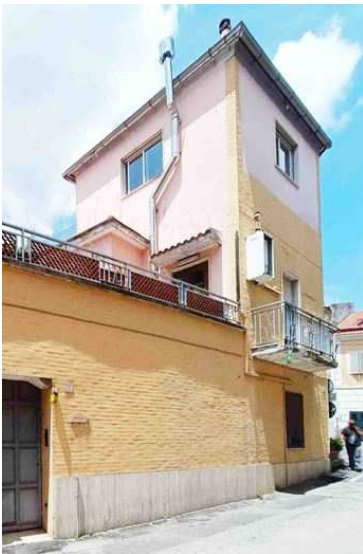
Prospetto sulla strada
