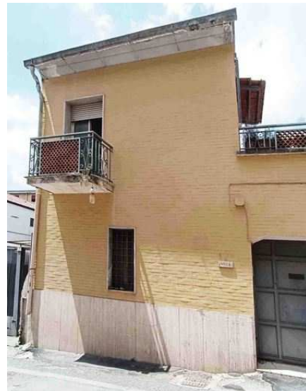
Prospetto sulla strada
