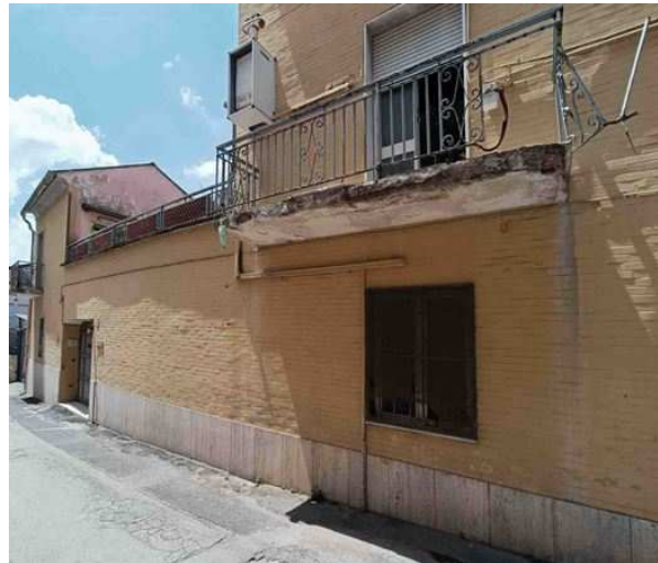
Prospetto sulla strada
