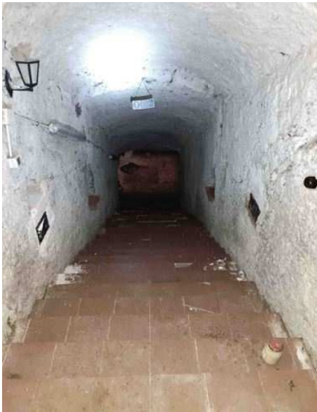
Scala di accesso alla cantina
