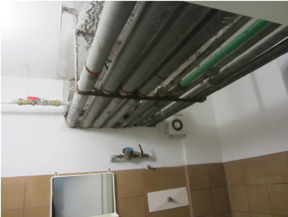
Foto n. 11, 12 – viste del bagno, al piano interrato
