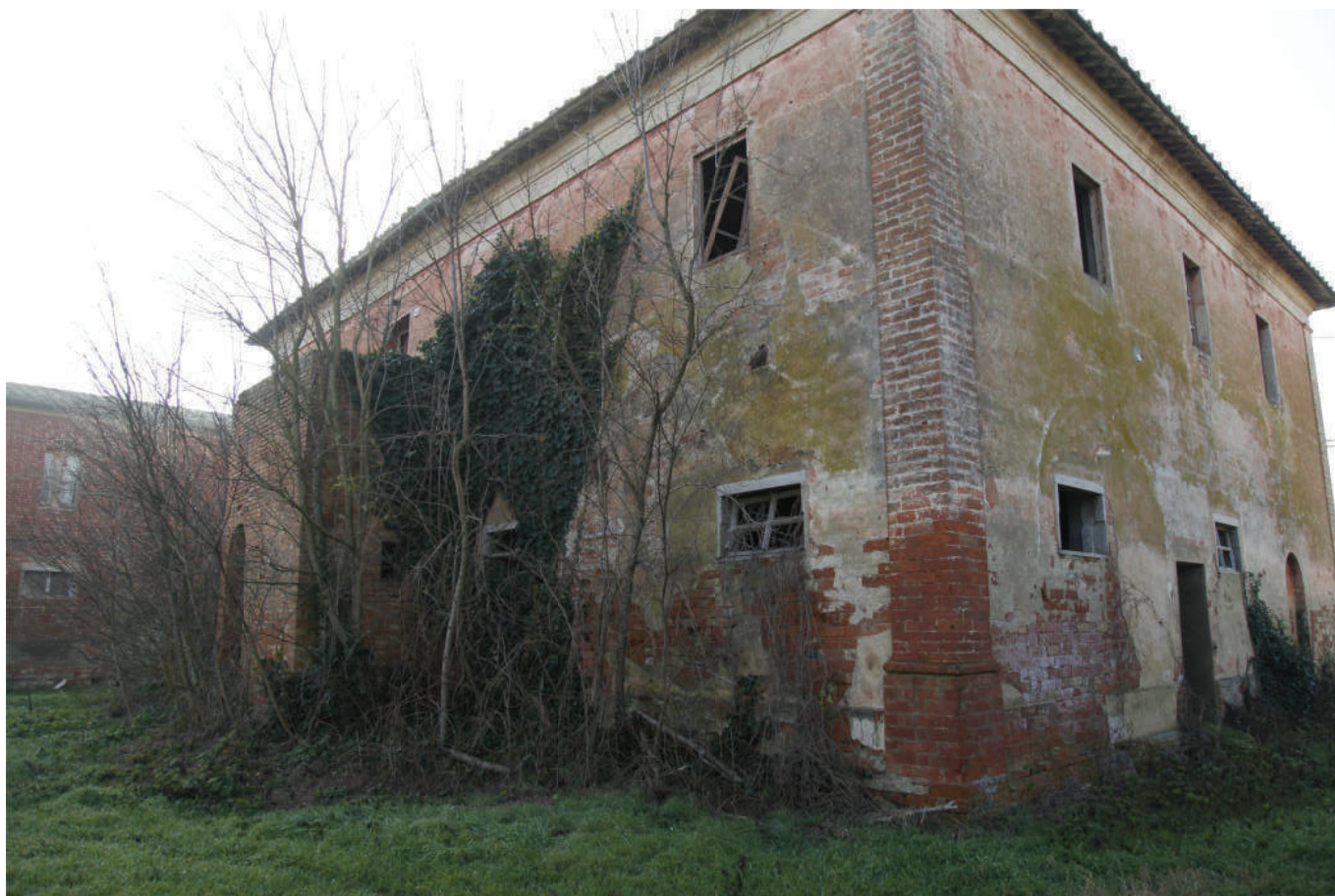
FOTO 12 - VISTA DEL FABBRICATO PRINCIPALE DA NORD-EST
