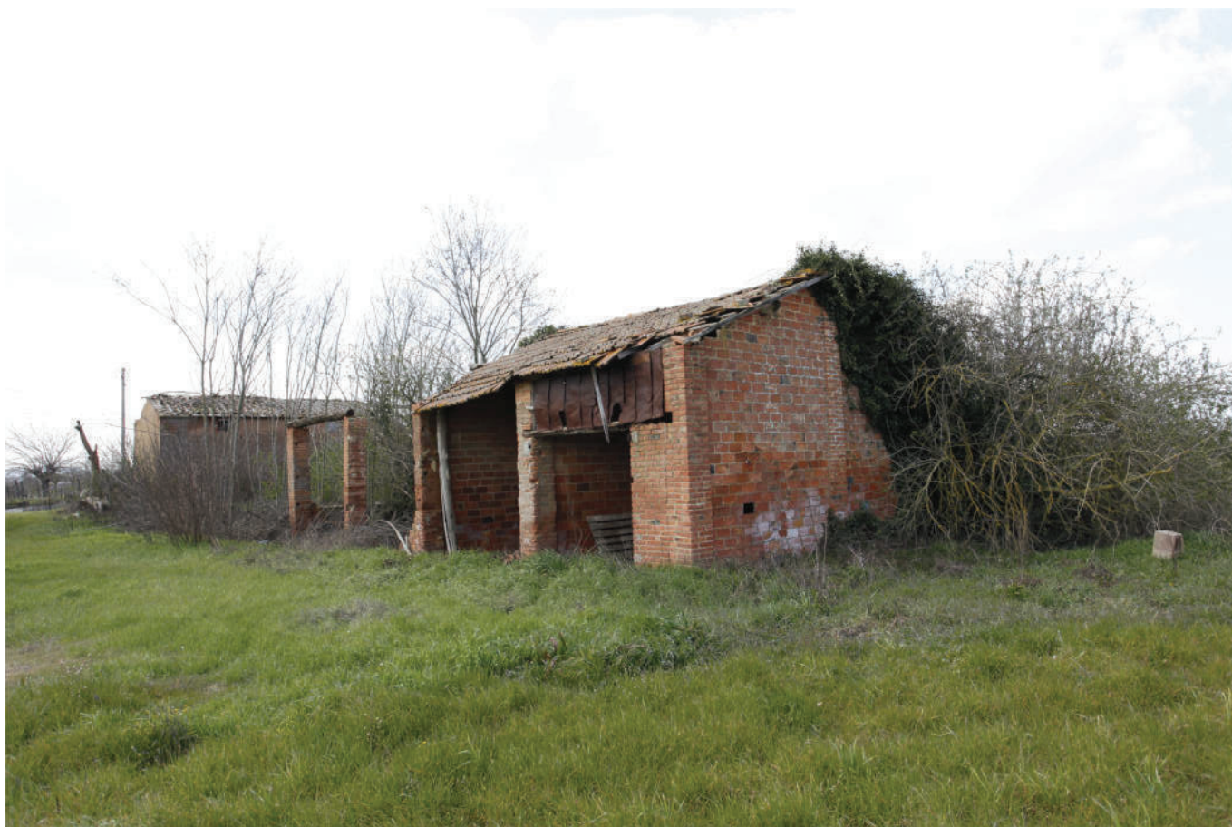
FOTO 30 - VISTA DELL'ANNESSO 3 DA EST
