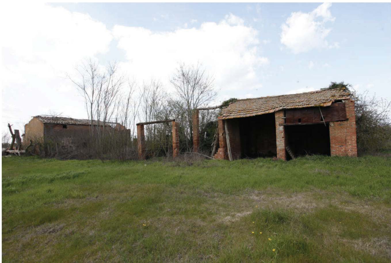
FOTO 29 - VISTA DEGLI ANNESSI 2 E 3 DA SUD
