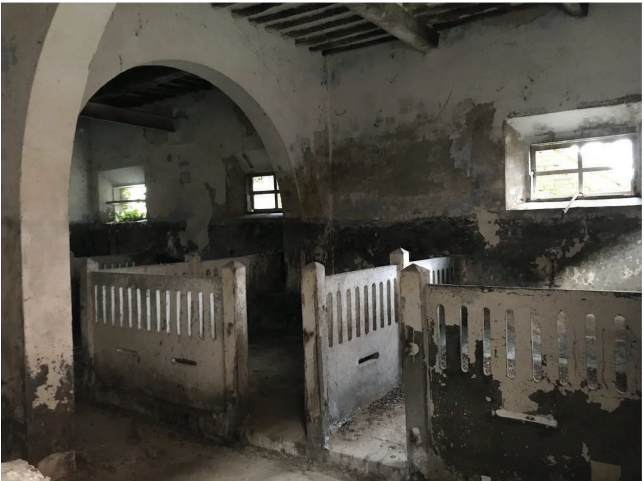
FOTO 20 - INTERNO DEL PANO TERRENO
