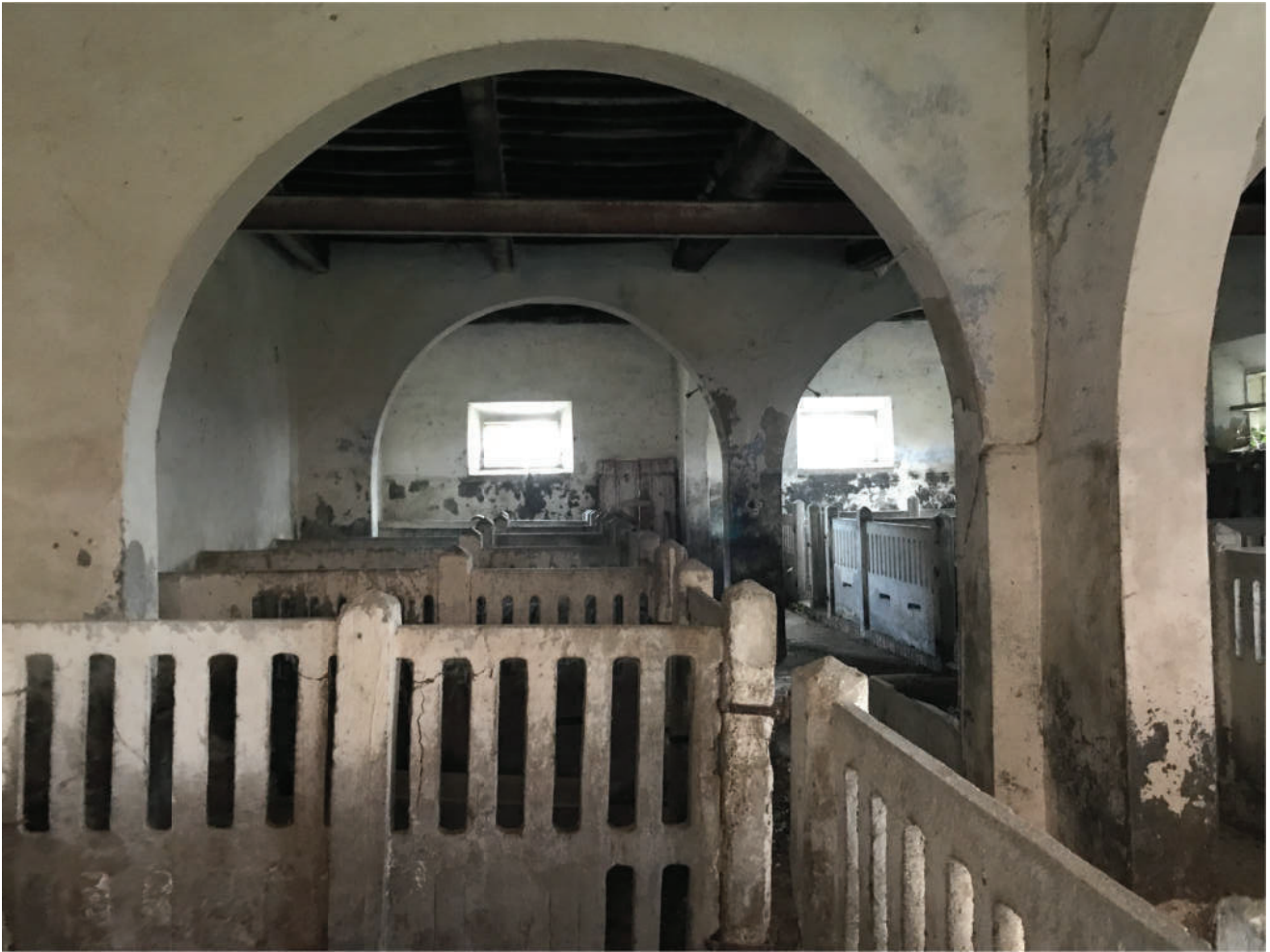
FOTO 19 - INTERNO DEL PANO TERRENO
