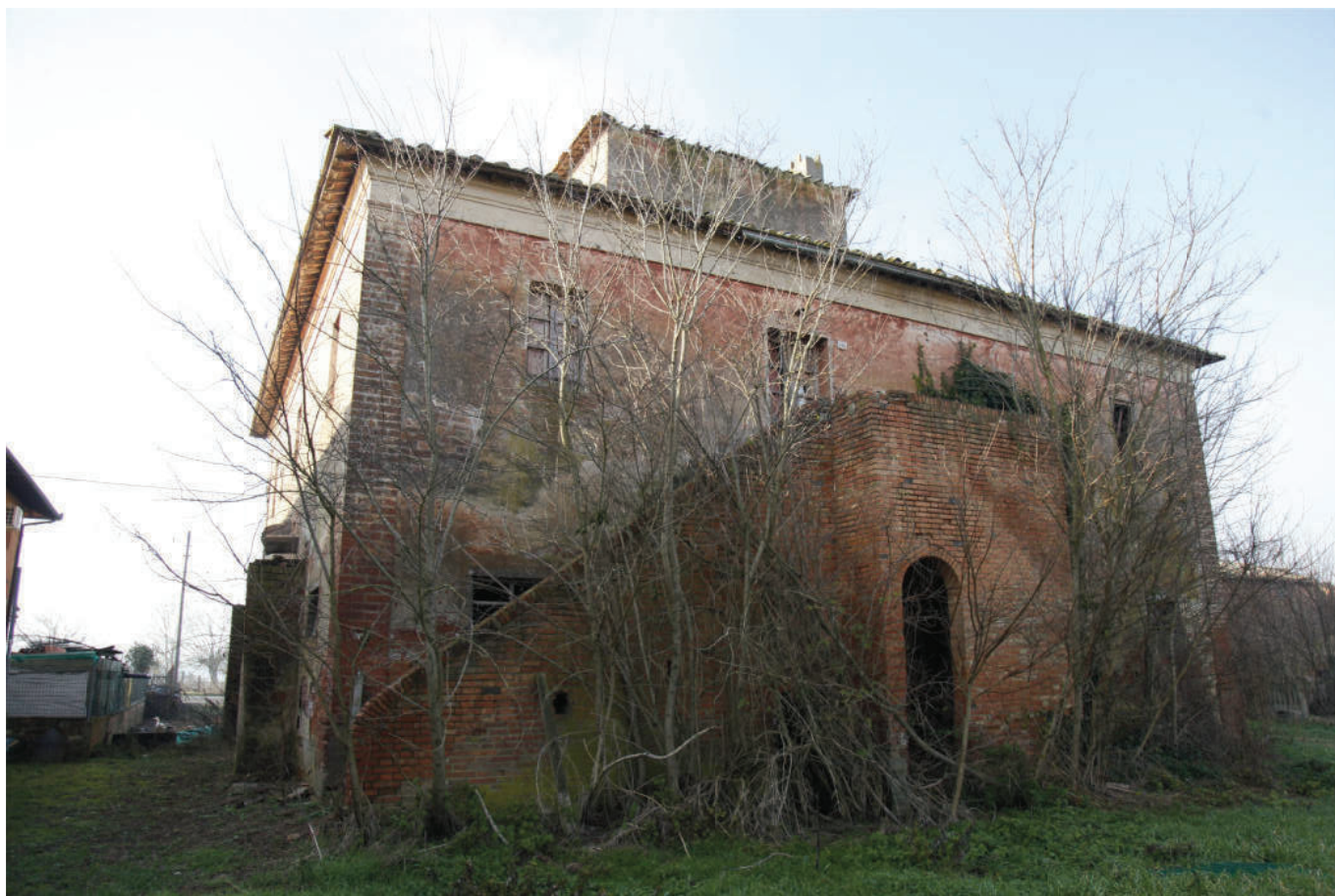
FOTO 13 - VISTA DEL FABBRICATO PRINCIPALE DA SUD-EST
