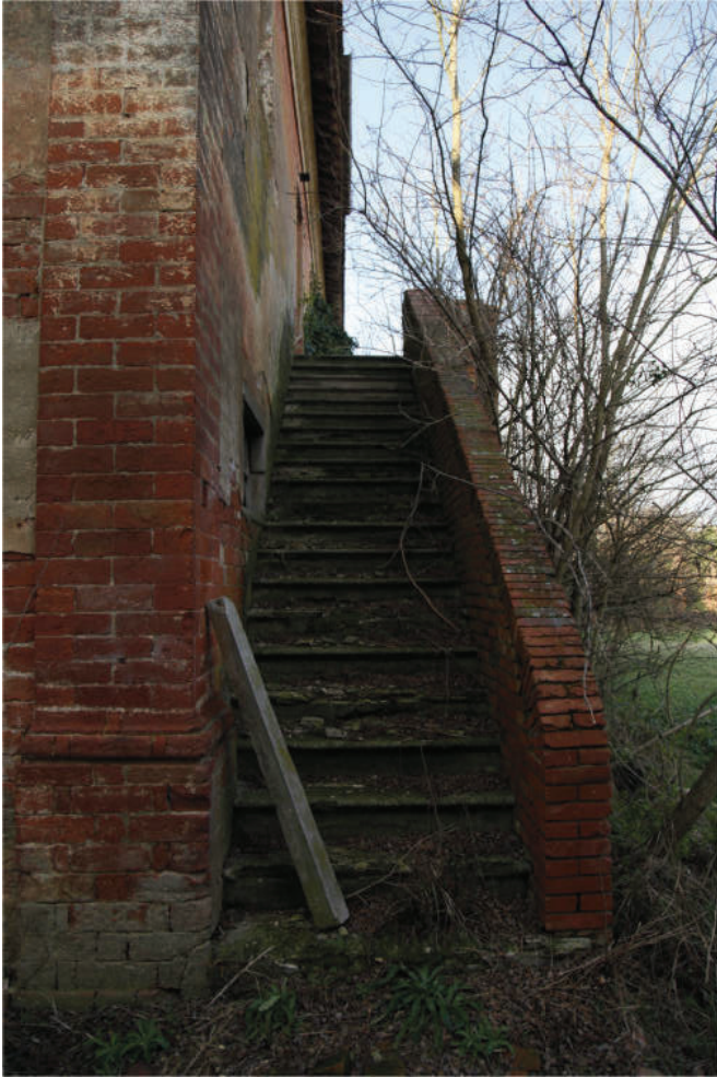
FOTO 15 - VISTA DELLA SCALA ESTERNA
