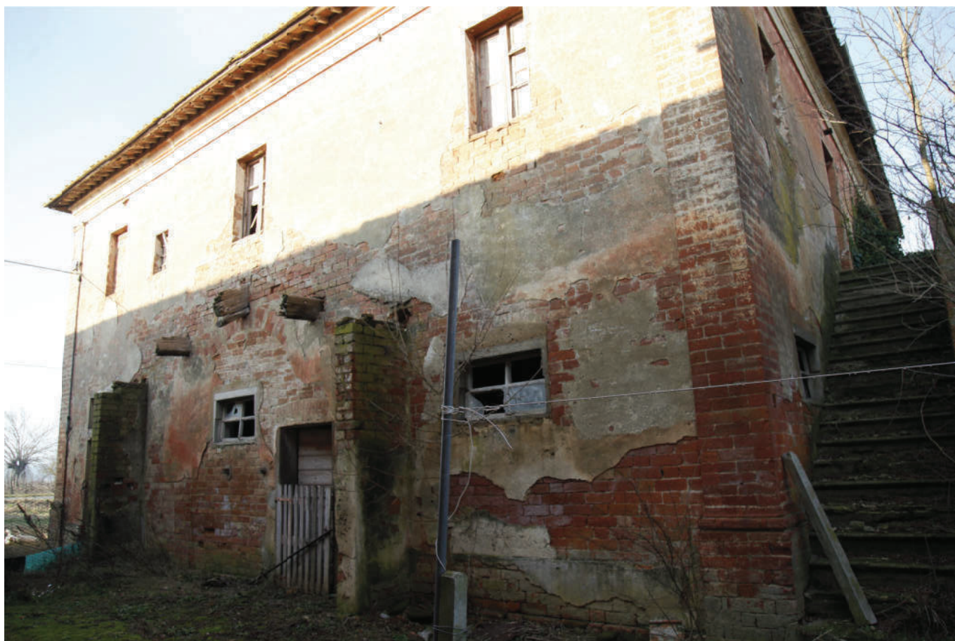
FOTO 14 - VISTA DEL FABBRICATO PRINCIPALE DA SUD
