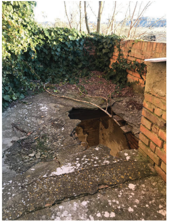
FOTO 16 - VISTA DEL TERRAZZO AL PIANO 1°
