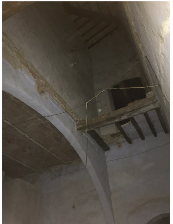
FOTO 18 - INTERNO DEL PIANO PRIMO
