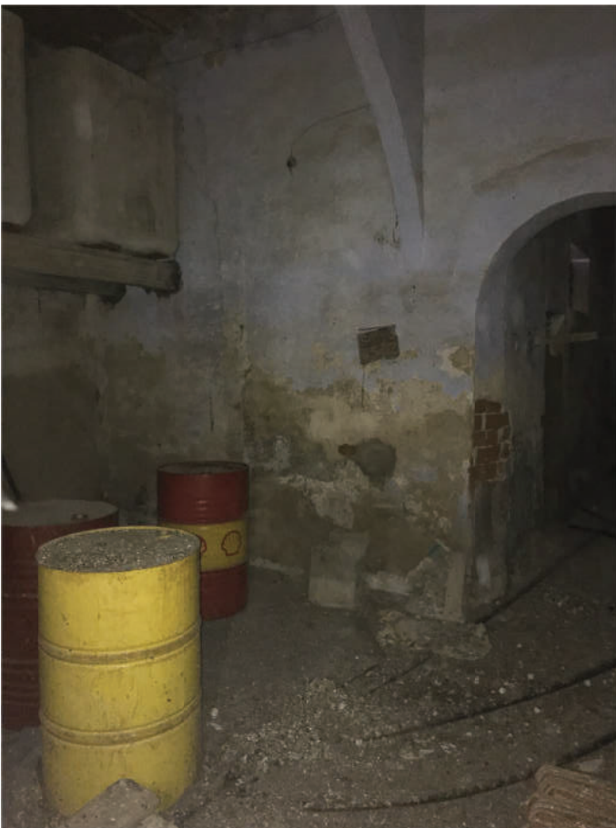
FOTO 17 - INTERNO DEL PIANO TERRENO
