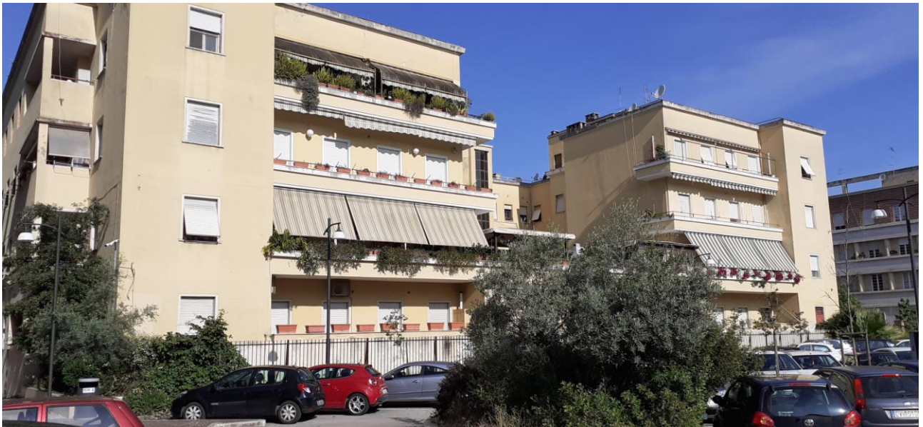
Vista N/E – Vista dell'intero fabbricato da Piazzale Nemo Cerasoli
