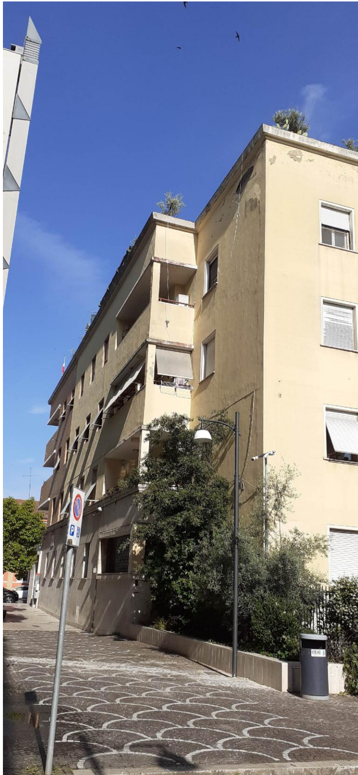
Facciata Sud/Est vista dal Piazzale Nemo Cerasoli
