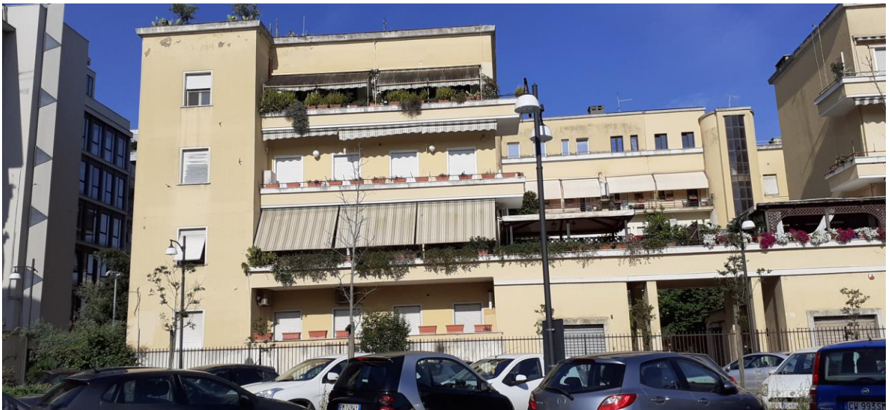
Facciata N/E vista dall'immobile a PT – rialzato
