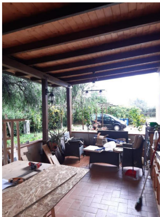
Foto esterna Abitazione – Tettoia abusiva (Bene n.1)
