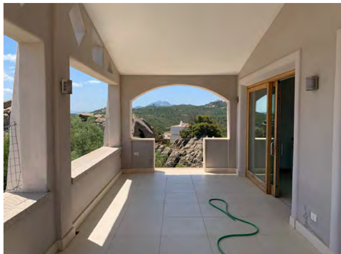
FOTO VERANDA PIANO PRIMO
