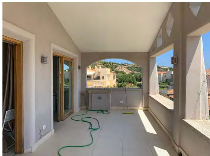
FOTO VERANDA PIANO PRIMO
