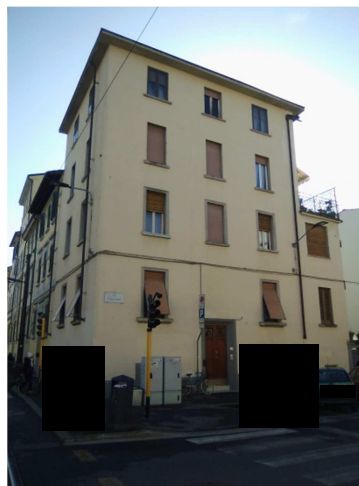
FOTO 4 Fronte edificio via C. Bini/ angolo Via V. Emanuele
