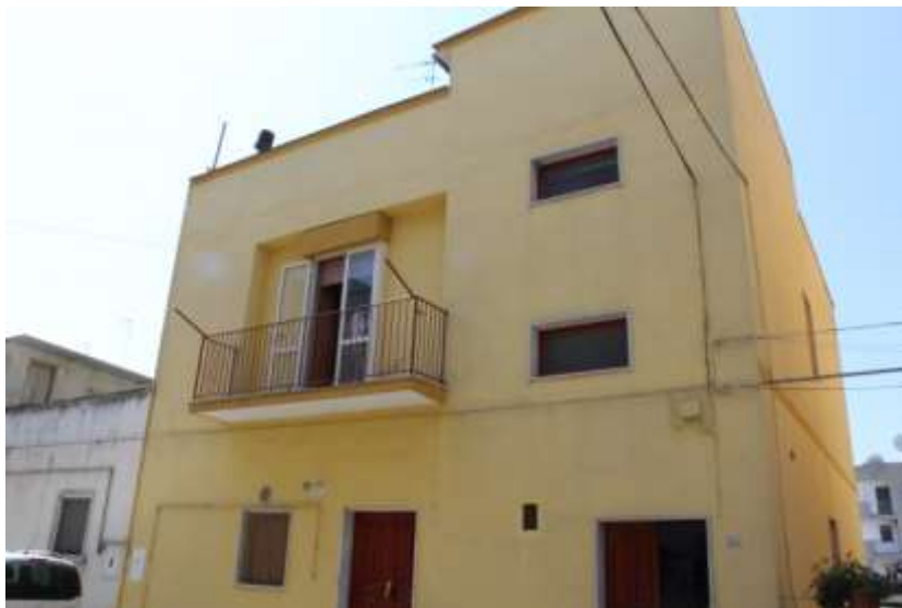
Foto 1 - Prospetto Via Napoli
