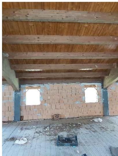
L'edificio la cui costruzione è stata sospesa per l'ordine di demolizione ricevuto, individuabile nella planimetria realizzata dai tecnici del Comune nei pressi dell'edificio principale si presenta come un grande spazio di circa 330 mq ad un piano rialzato ed altri 330 al piano seminterrato. Le tamponature laterali sono rimaste incomplete e l'unico elemento costruttivo completato il tetto composto da travi principali in legno lamellare.
