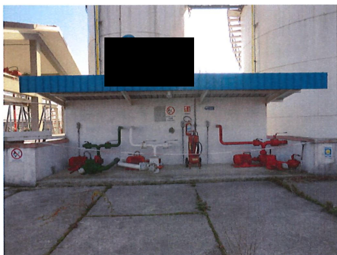
pensilina scarico carburanti
