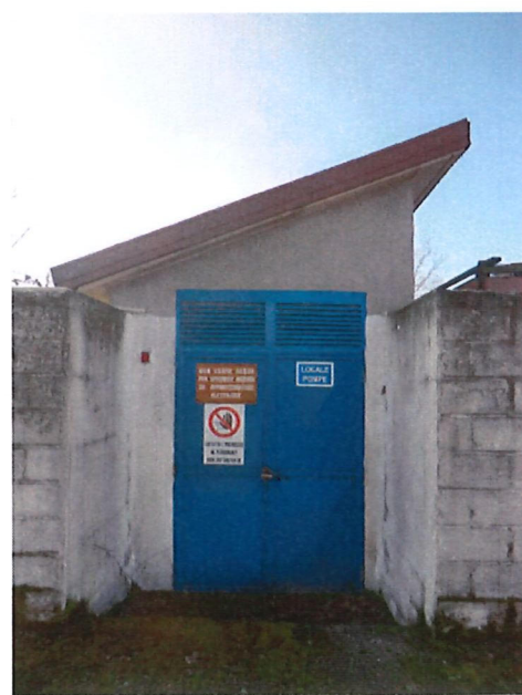
esterno locale pompa antincendio
