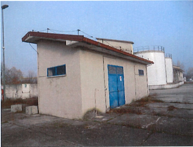
locale deposito Kerosene
