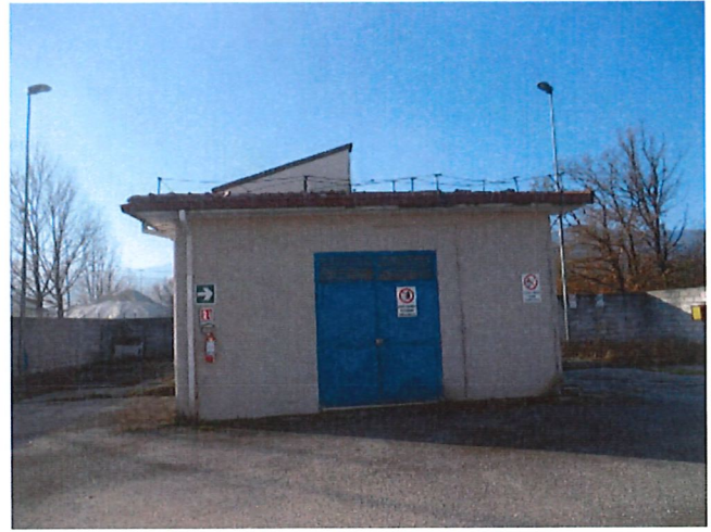
locale deposito olii lubrificanti
