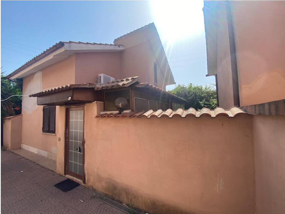
Foto 2 _ Vista esterna _ Ingresso
