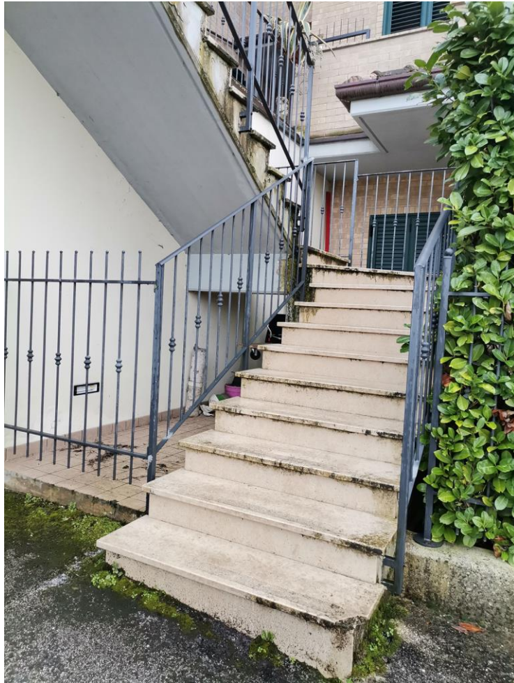
Foto n. 9: Scala esterna condominiale
