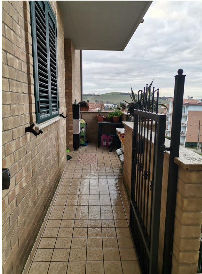
Foto n. 11: Ballatoio di ingresso esclusivo
