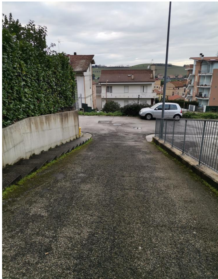
Foto n. 8: Rampa di accesso pedonale
