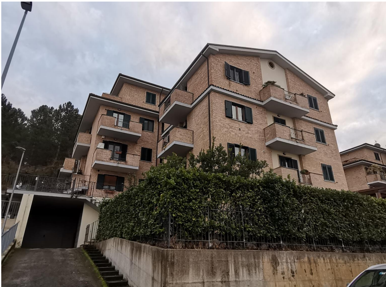
Foto n. 4: Prospetti nord-ovest fabbricato
