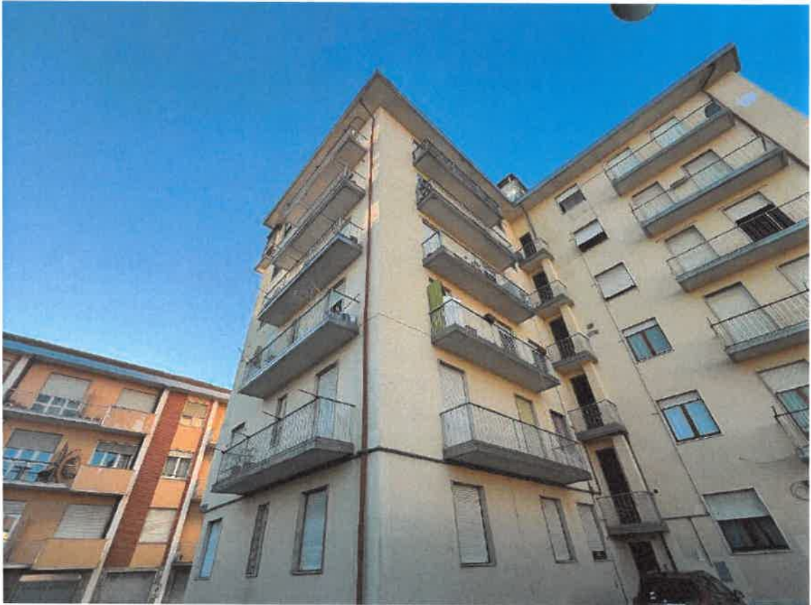
Figura 2 veduta stabile condominiale
