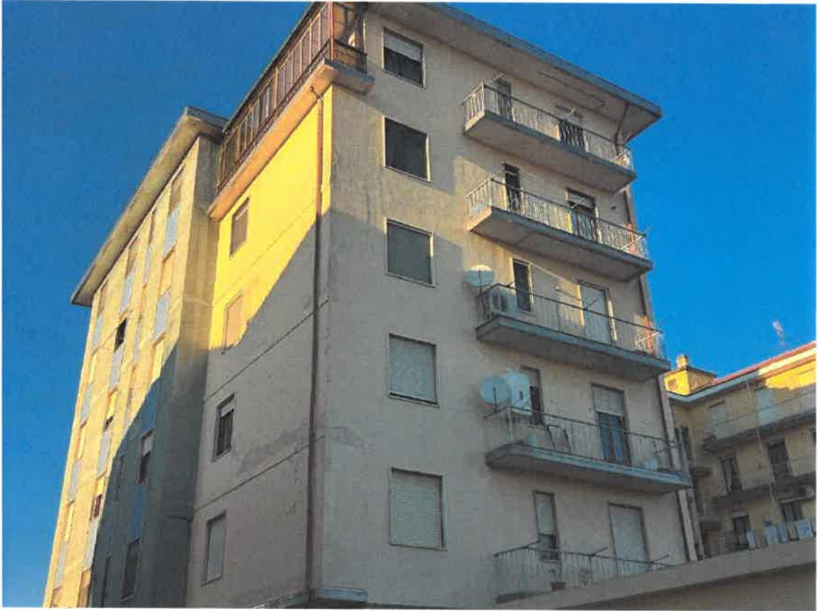
Figura 1 veduta stabile condominiale
