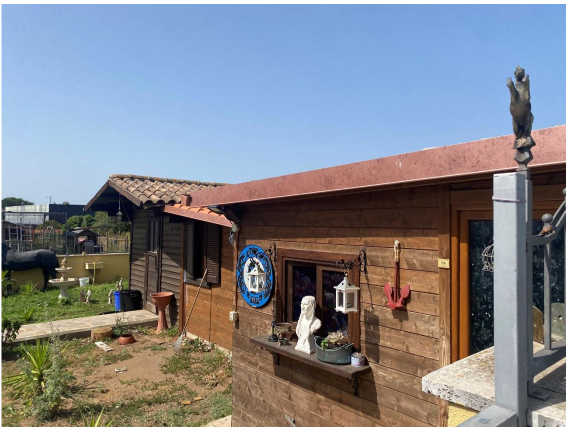
Foto 4 _ Vista esterna _ Edificio G4
