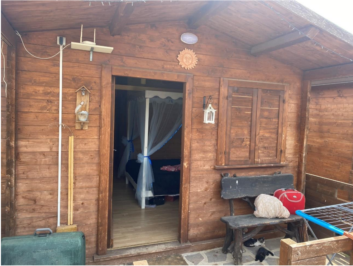
Foto 5 _ Vista esterna _ Edificio G1
