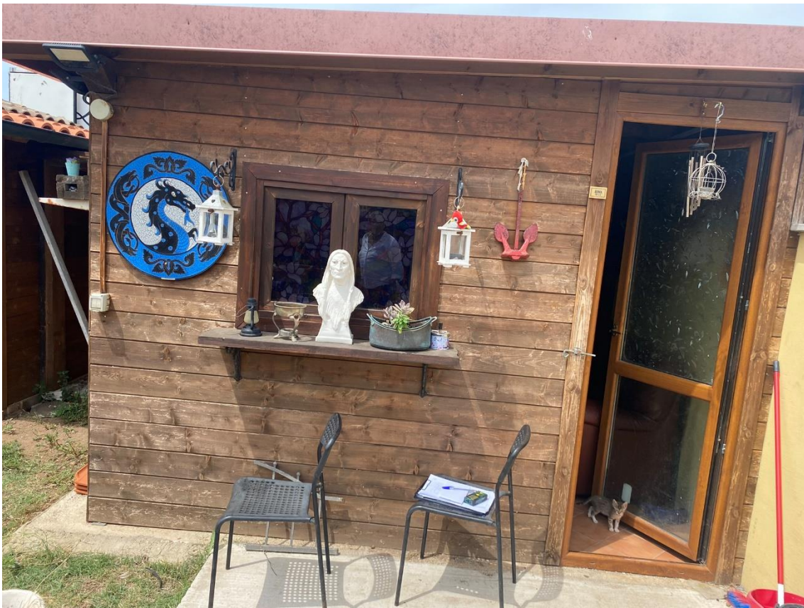
Foto 8 _ Vista esterna _ Edificio G4
