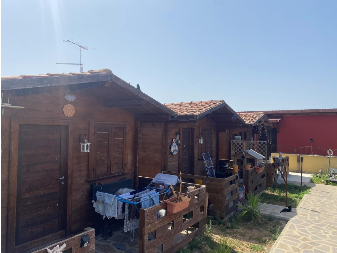
Foto 3 _ Vista esterna _ Edificio G1
