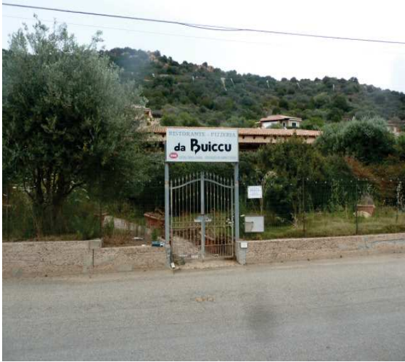
Foto n. 9 ingresso via Pascoli
