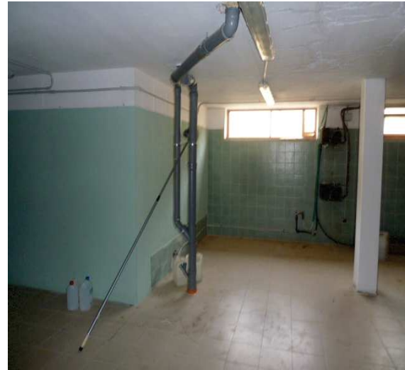
Foto n. 8 solaio piano interrato
