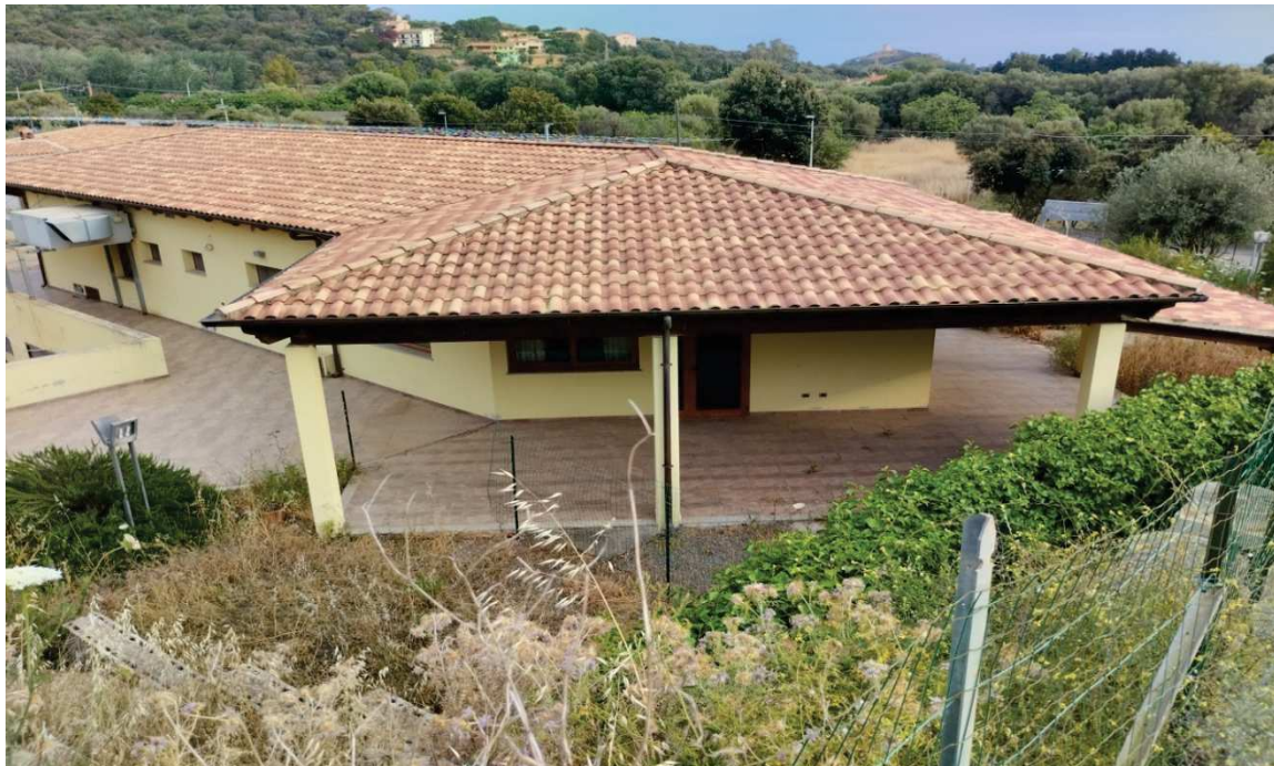
Foto n. 4 Copertura del fabbricato
