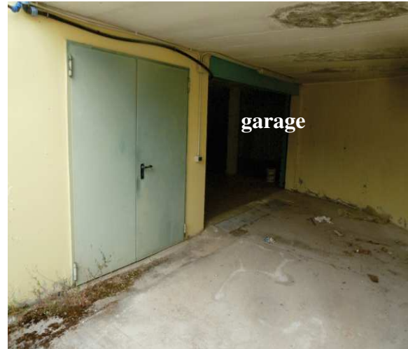
Foto n. 36 vano tecnico e garage
