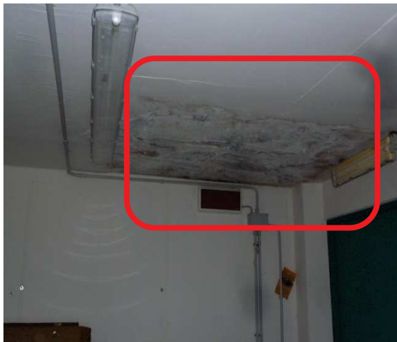
Foto n. 41 infiltrazioni garage
