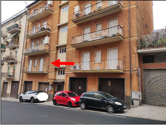
Foto n. 1 (esterno edificio vista frontale)
