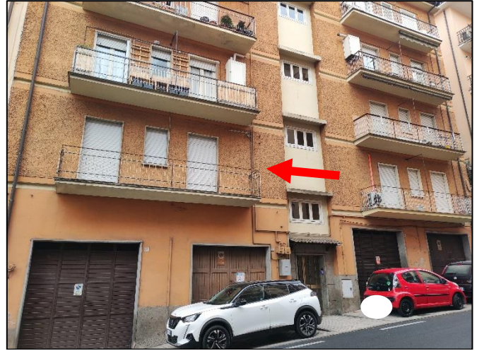
Foto n. 2 (esterno edificio vista frontale)
