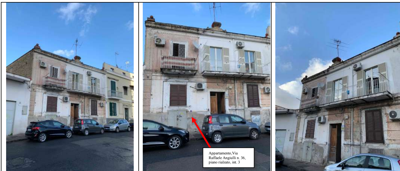
Foto 4, 5, 6: Viste fabbricato da Via Raffaele Angiulli
