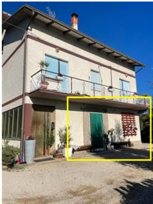
INGRESSO APPARTAMENTO AL PIANO TERRA
