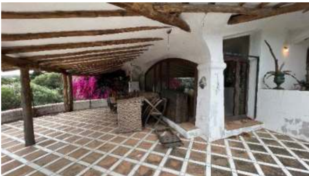
Figura 24 – Viste delle verande esterne accessibili dal soggiorno volte verso Est
