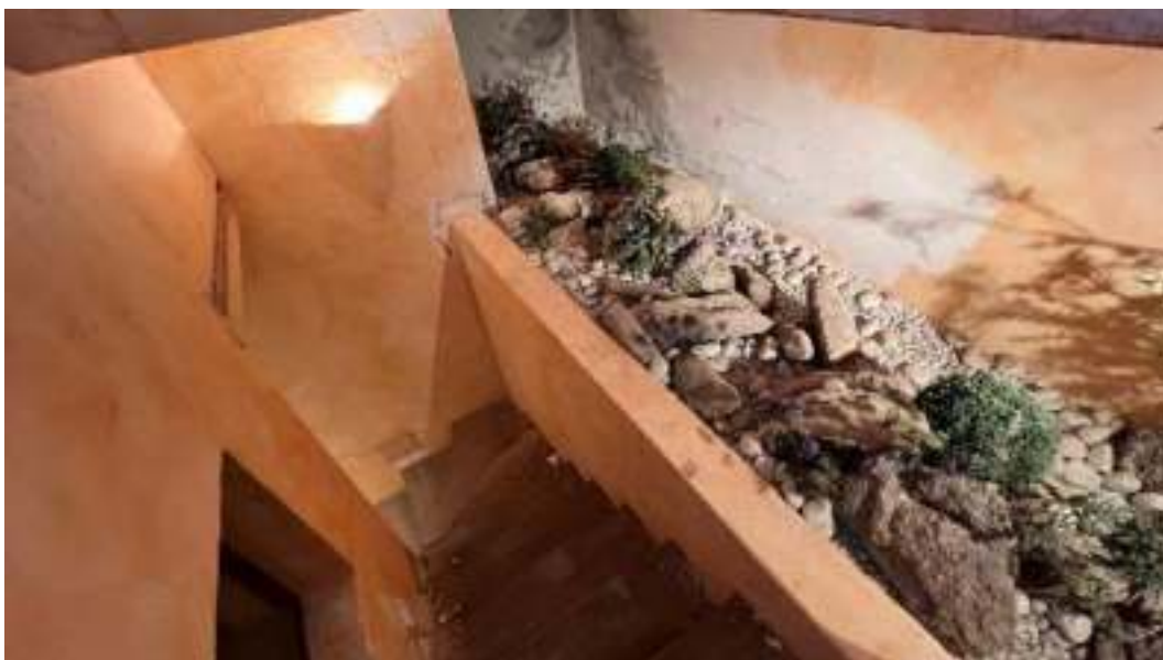
Figura 43 – Viste delle scale di collegamento tra piano terra e piano seminterrato
