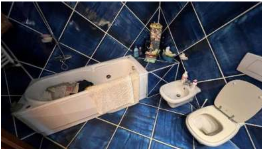
Figura 35 – Viste del piano terra, del bagno 2
