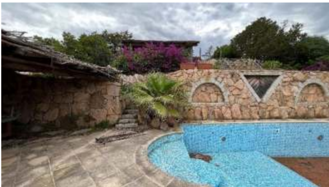
Figura 23 – Viste delle facciate del fronte Nord del bene
