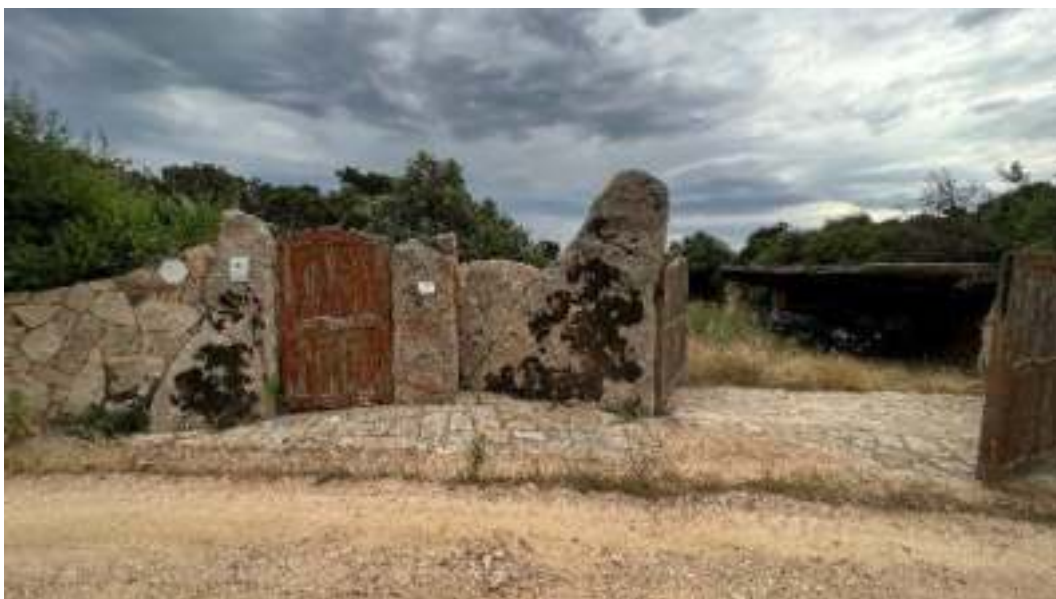
Figura 6 – Ulteriori viste della recinzione esterna degli ingressi sia pedonali sia carrabili del bene
