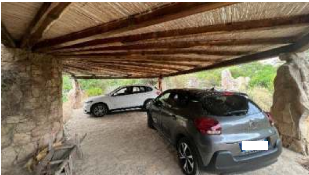
Figura 14 – Viste dell'area destinata a parcheggio coperto
