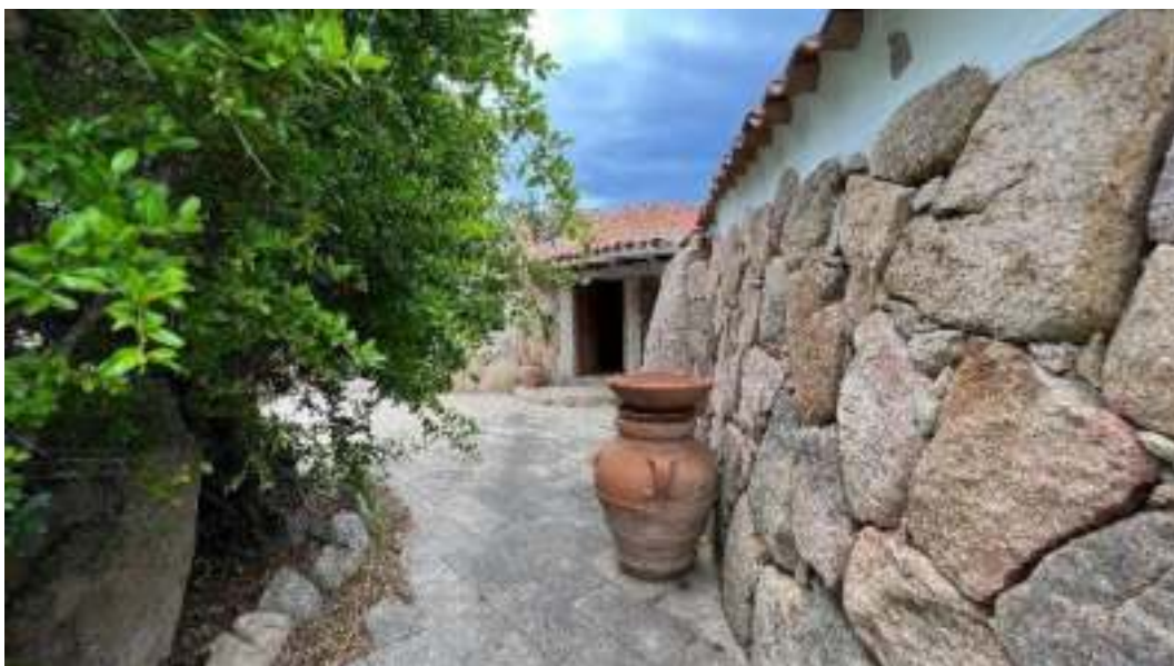
Figura 20 – Ulteriori viste delle facciate del fronte Ovest del bene
