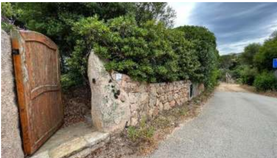
Figura 5 – Viste della recinzione esterna degli ingressi pedonali del bene
