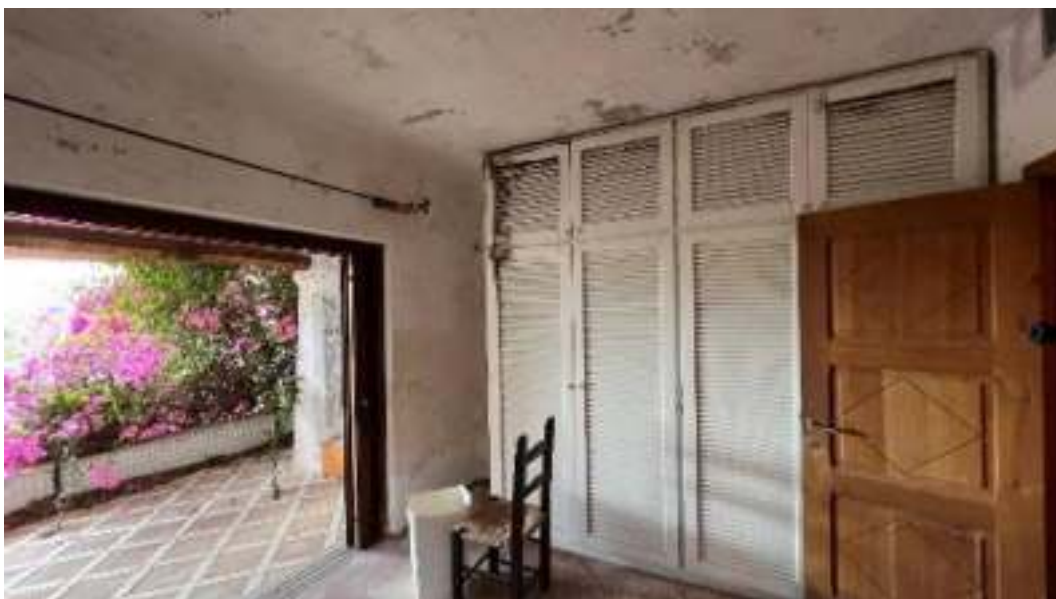
Figura 37 – Viste del piano terra, della camera 3
