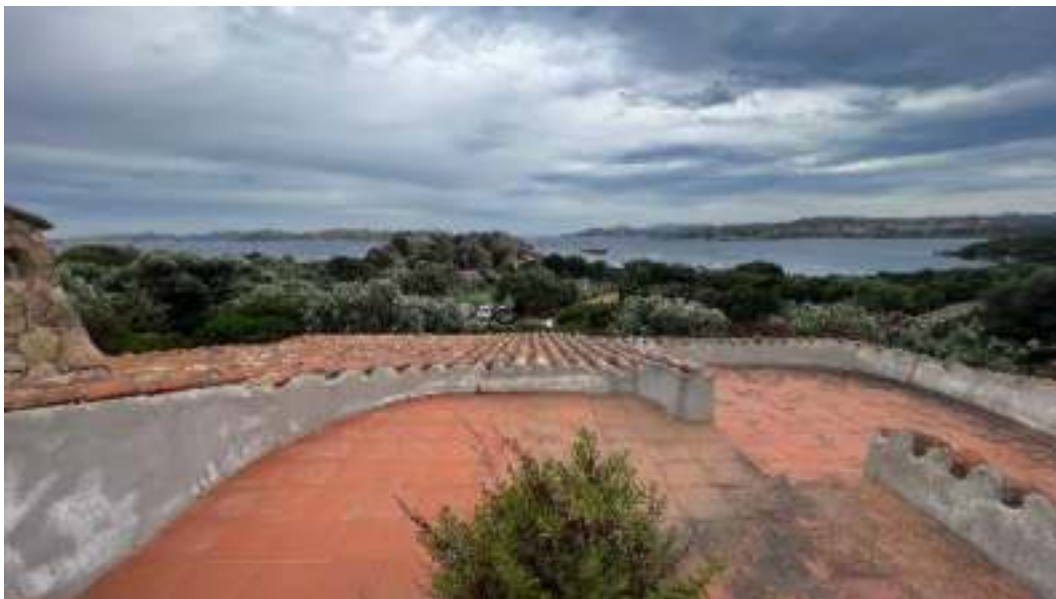
Figura 11 – Viste dal piano di copertura
