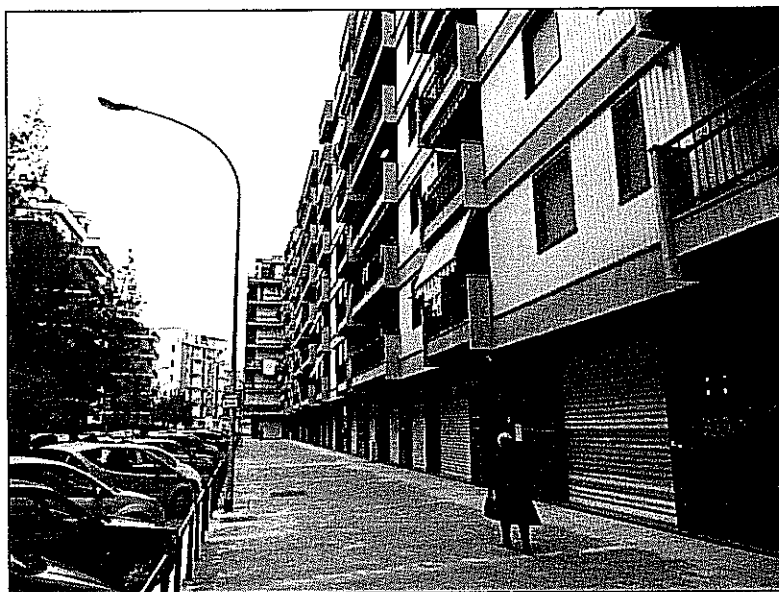
Figura n° 15. Fotografia del fabbricato sito in Via E. Nardella.
