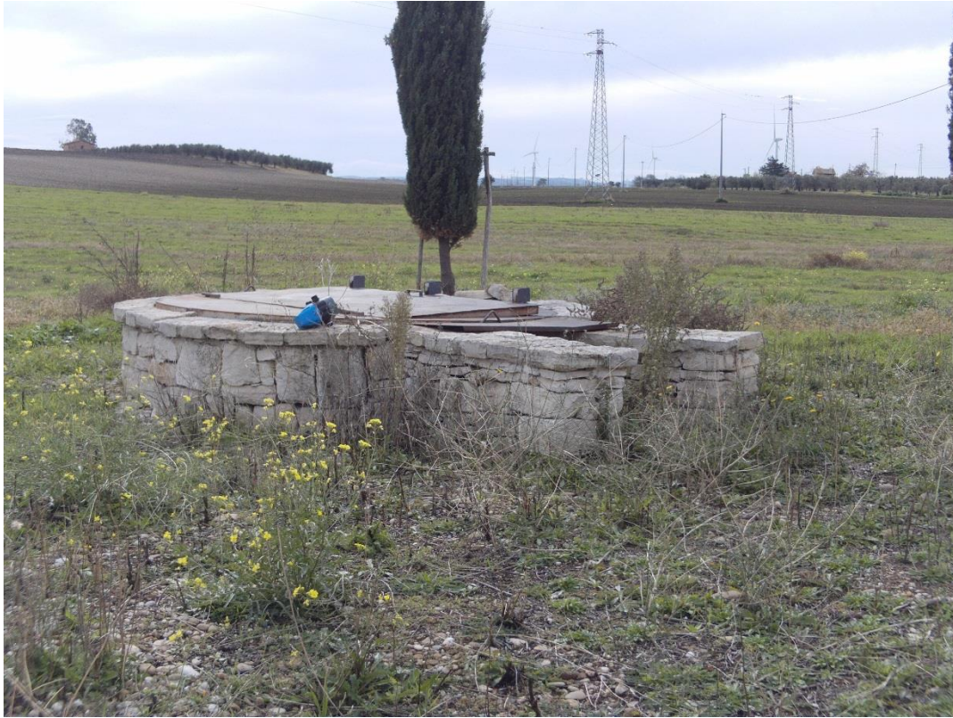
Particella 397, seminativo – pozzo
