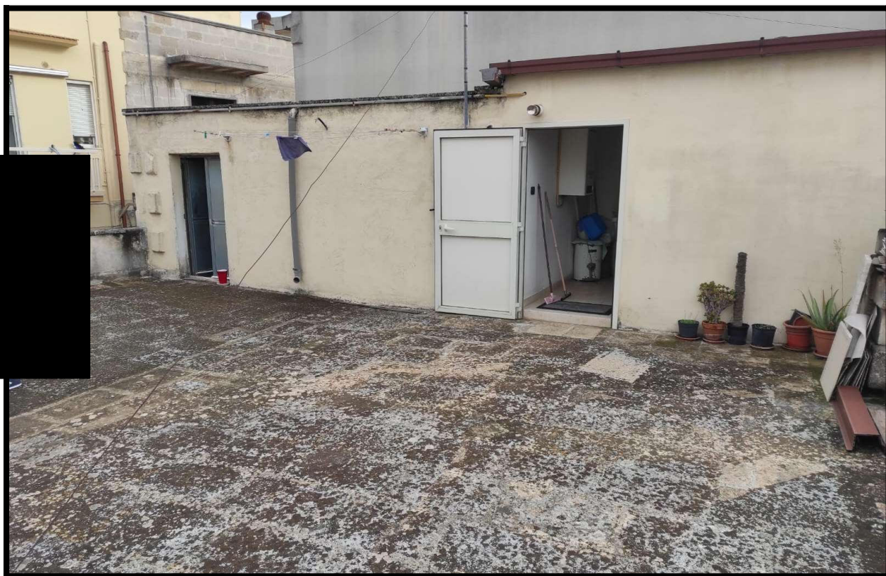
-Vista Interna – Piano Terrazza – Lastrico solare
