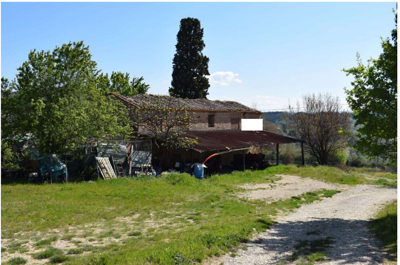
Foto n. 44_ Sopralluogo del 19/04/2019 Podere Capaccia, il fienile sub 7, con la tettoia e il resede esterno (sub 6) a comune con la casa colonica
