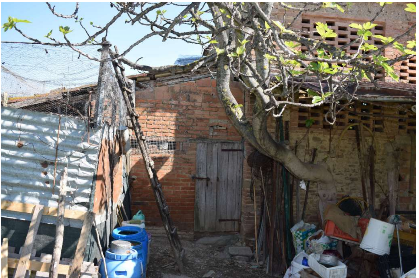
Foto n. 46_ Sopralluogo del 19/04/2019 Podere Capaccia, il piccolo deposito terminale addossato al fienile
