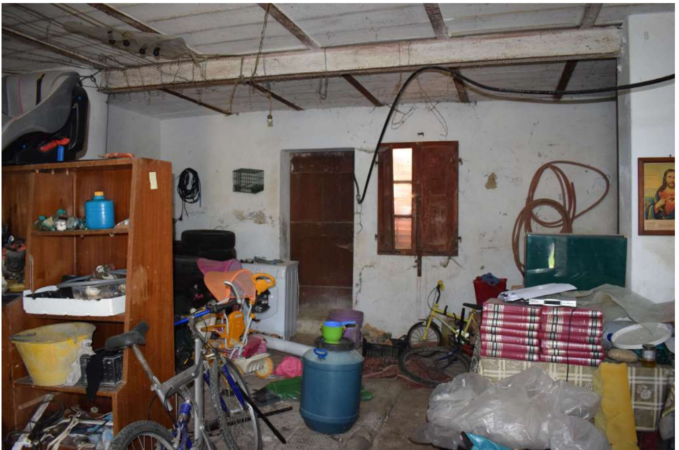
Foto n. 16_ Sopralluogo del 19/04/2019 Podere Capaccia: la casa colonica, magazzino frontale (sub 3). In fondo la porta di collegamento con i depositi lato tergaie
