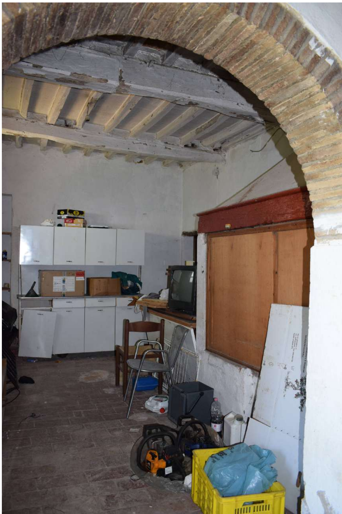
Foto n. 28_ Sopralluogo del 19/04/2019 Podere Capaccia, casa colonica, appartamento sub 5, numero civico 99: piano terra, stanza a sinistra dell'ingresso
