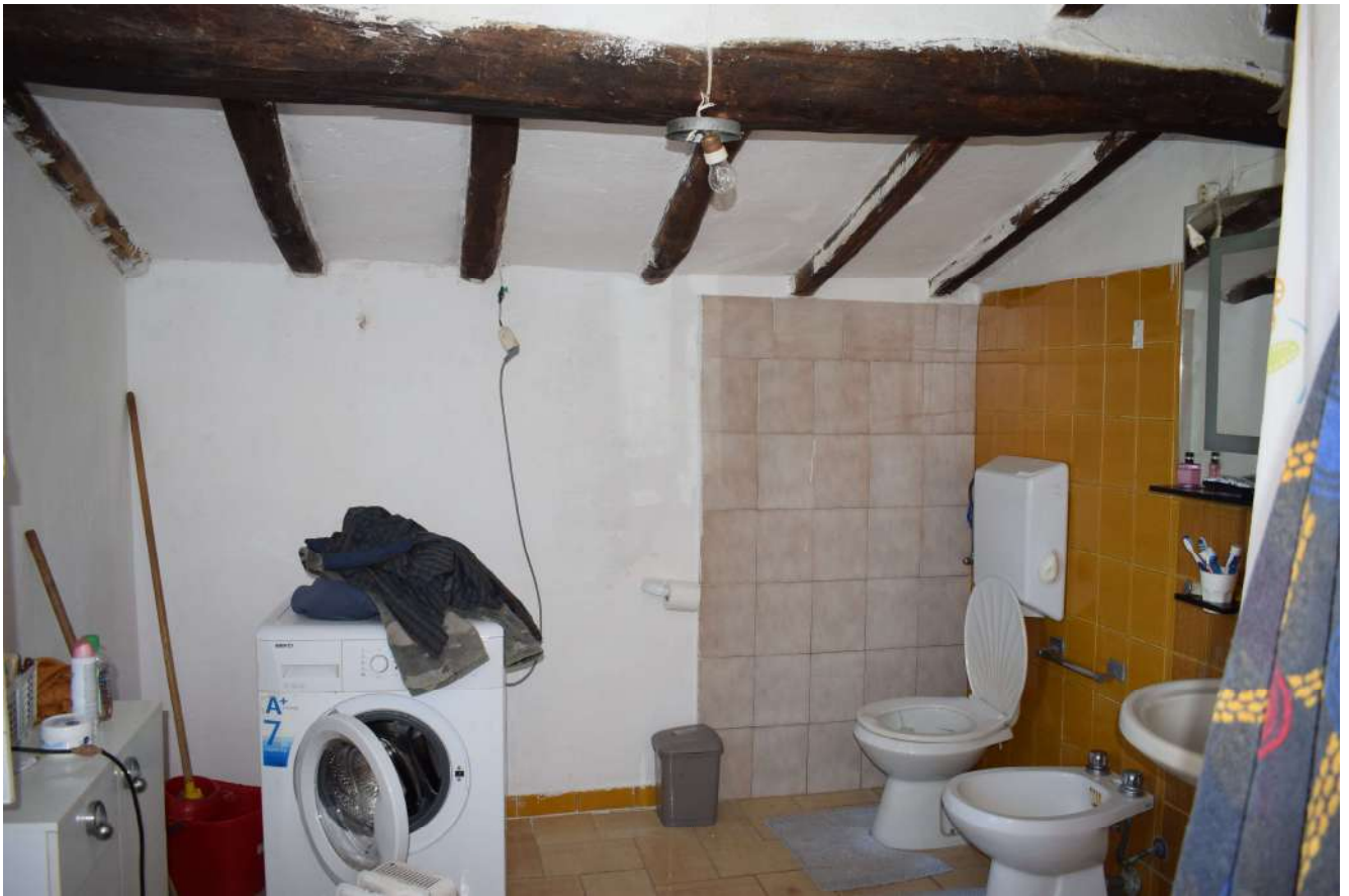
Foto n. 19_ Sopralluogo del 19/04/2019 Podere Capaccia, casa colonica, appartamento al piano primo (sub 4): il bagno
