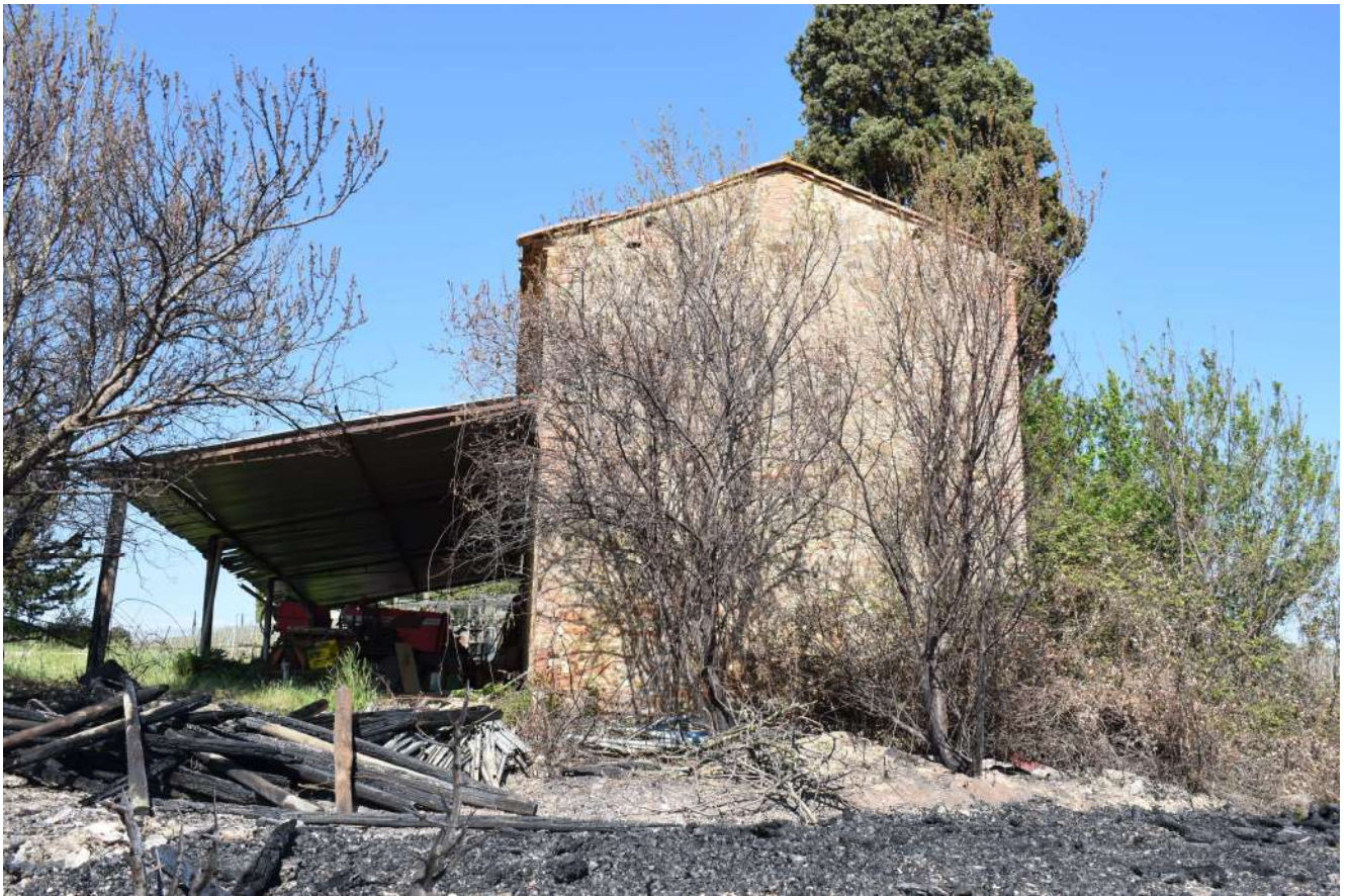
Foto n. 47_ Sopralluogo del 19/04/2019 Podere Capaccia, il fienile e la tettoia
