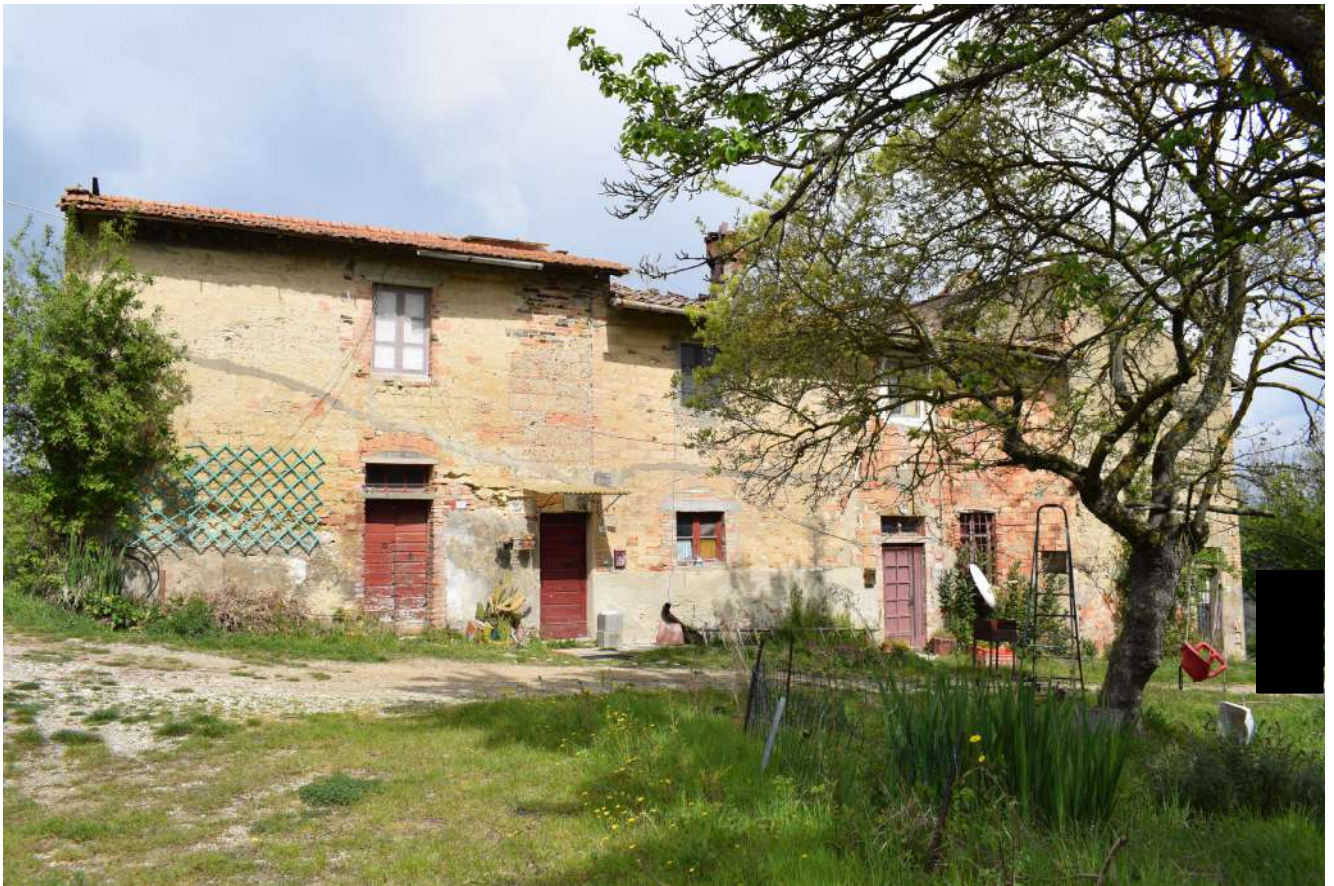
Foto n. 5_ Sopralluogo del 19/04/2019 Podere Capaccia: la casa colonica, facciata
