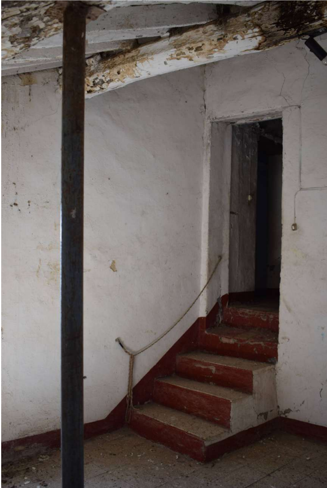
Foto n. 33_ Sopralluogo del 19/04/2019 Podere Capaccia, casa colonica, appartamento sub 5: piano primo, la stanza della foto precedente è su un livello diverso
