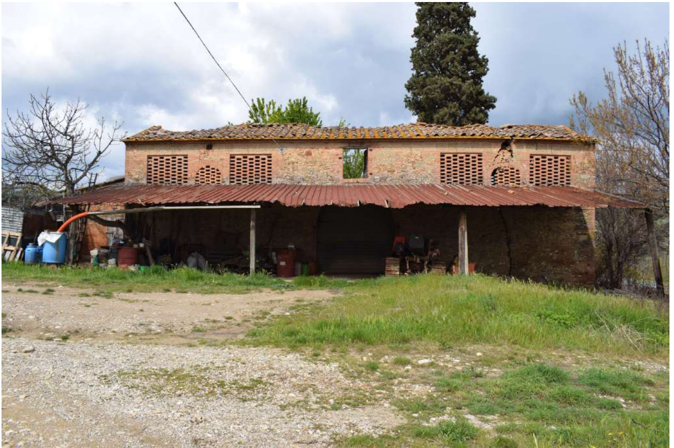
Foto n. 43_ Sopralluogo del 19/04/2019 Podere Capaccia, il fienile sub 7 visto dal resede a comune con la casa colonica
