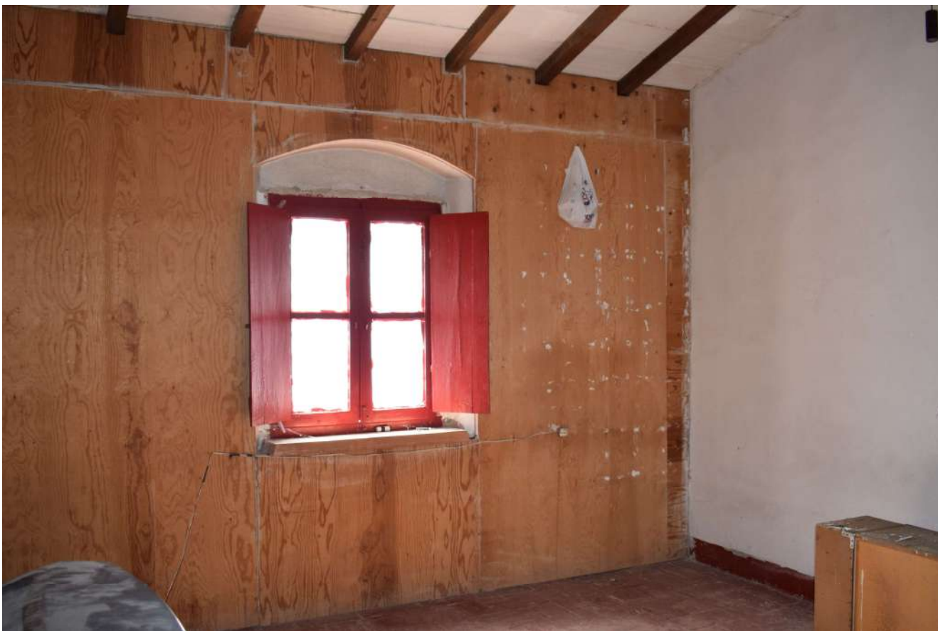
Foto n. 35_ Sopralluogo del 19/04/2019 Podere Capaccia, appartamento sub 5, piano primo
