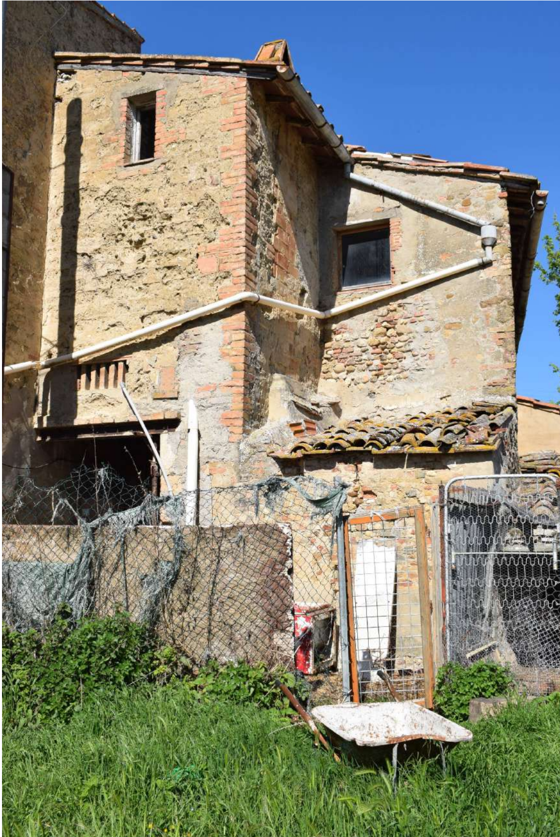
Foto n. 7_ Sopralluogo del 19/04/2019 Podere Capaccia: la casa colonica, vista laterale
