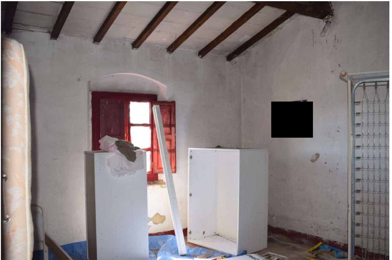
Foto n. 36_ Sopralluogo del 19/04/2019 Podere Capaccia, appartamento sub 5, piano primo
