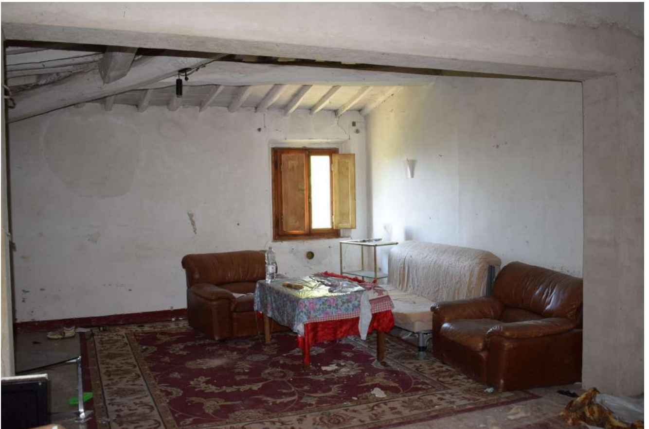
Foto n. 37_ Sopralluogo del 19/04/2019 Podere Capaccia, appartamento sub 5, piano primo
