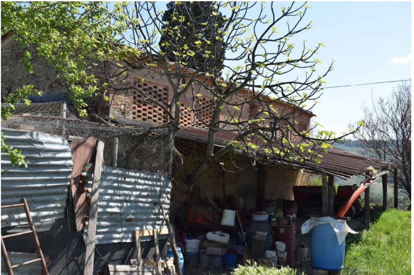
Foto n. 45_ Sopralluogo del 19/04/2019 Podere Capaccia, il fienile sub 7, con superfetazioni e volumi addossati
