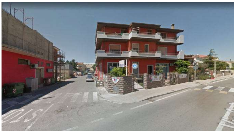
FOTO 02 - VISTA DALLA VIA SAN SPERATE IMMOBILI 1-2-3-4
