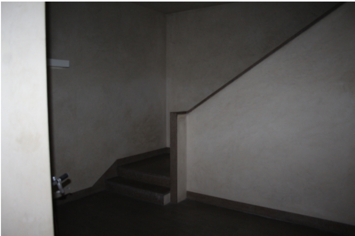
vano scala comune
