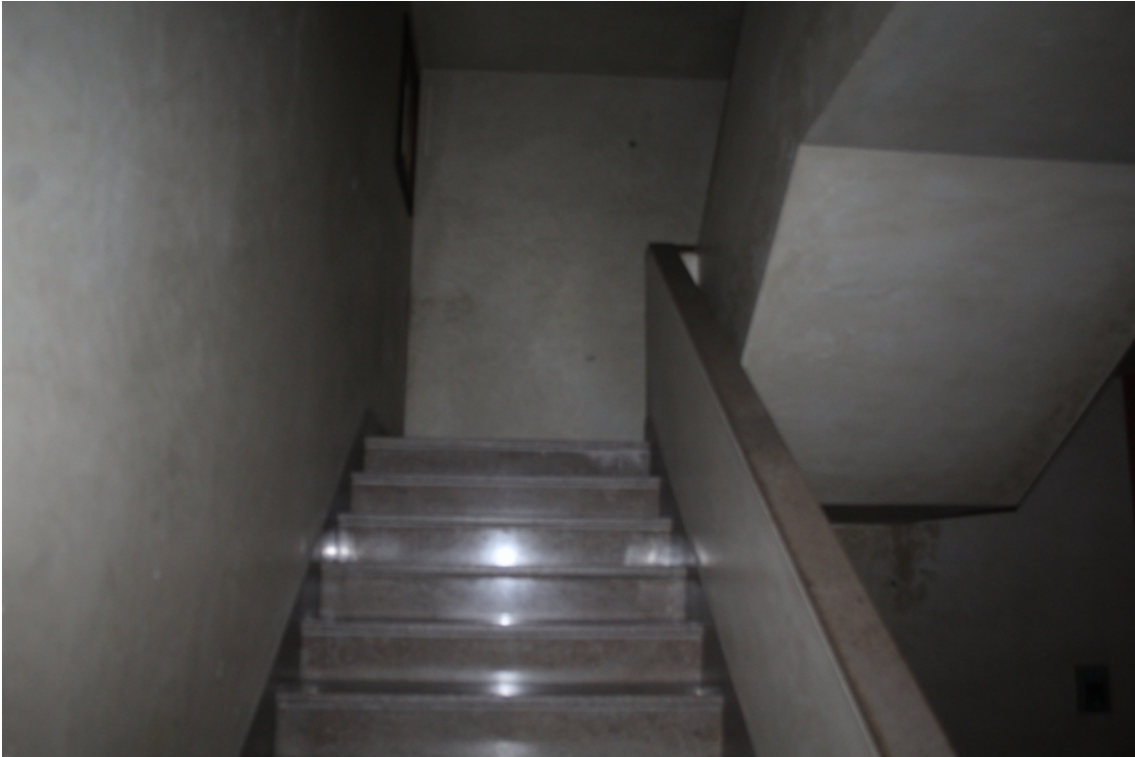
vano scala comune
