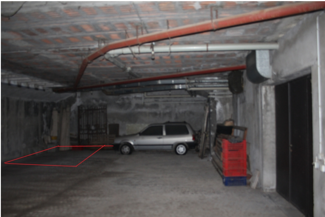
posto auto coperto piano seminterrato
