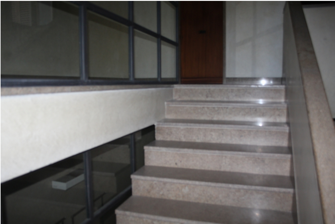
vano scala comune
