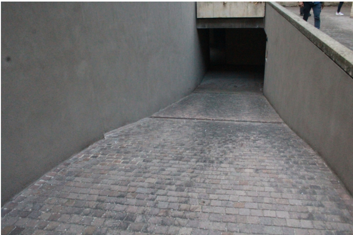
rampa esterna di accesso al piano seminterrato
