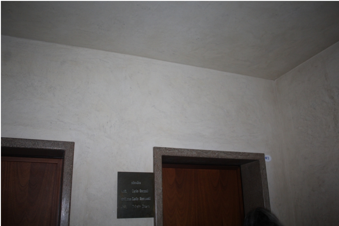
ingresso studio piano primo interno 3
