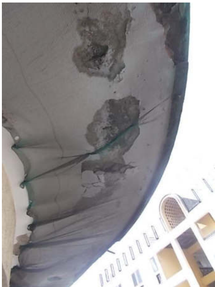
particolari distacco intonaco del soffitto del balcone
