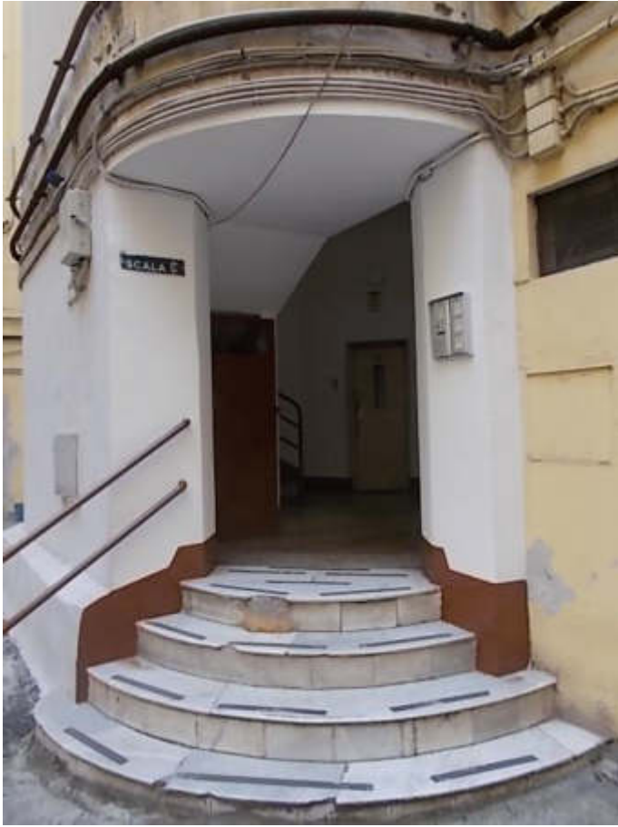
ingresso alla scala C dal cortile
