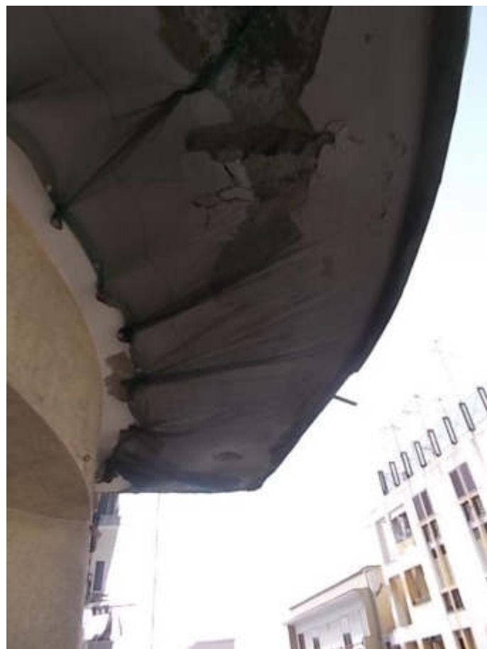
particolari distacco intonaco del soffitto del balcone
