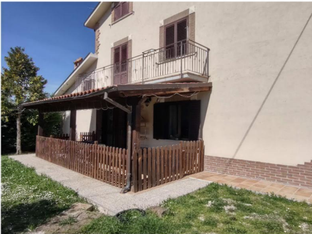
Foto n. 17: visuale portico laterale
