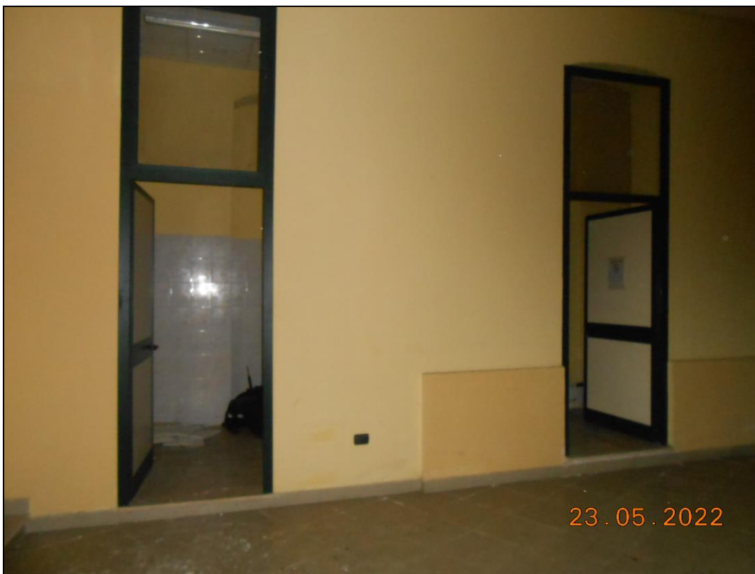
FOTO N. 32 Vista interna dei locali dell'immobile.
