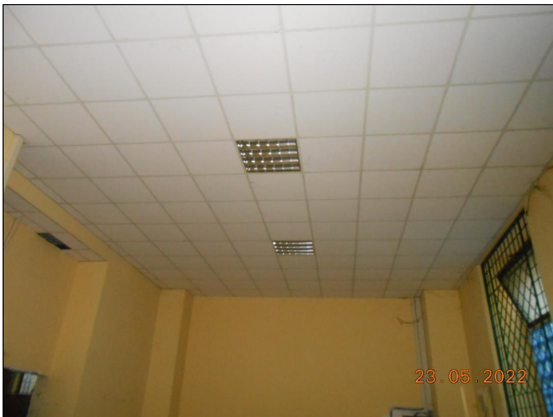
FOTO N. 24 Vista interna dei locali dell'immobile. Si nota la controsoffittatura con pannelli fonoassorbenti.
