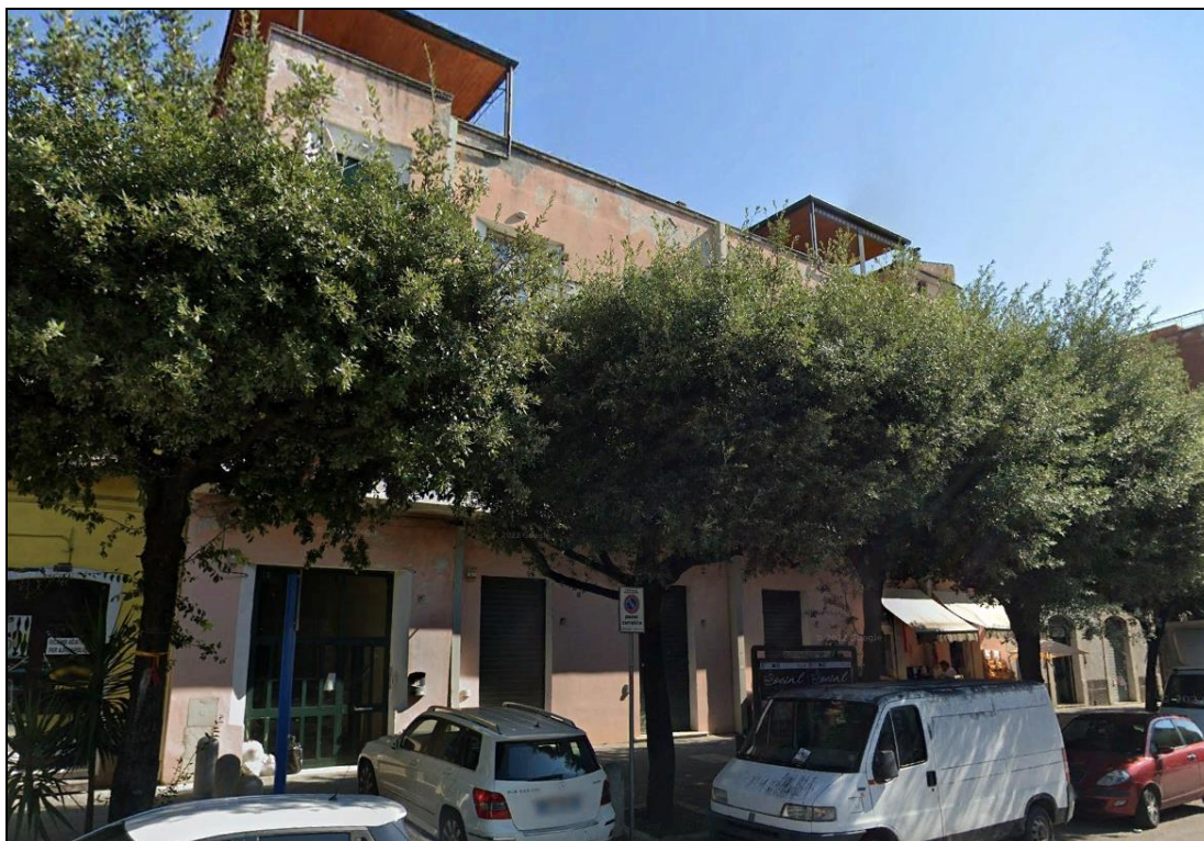
FOTO N. 05 Vista dell'immobile pignorato a piano terra del fabbricato.
