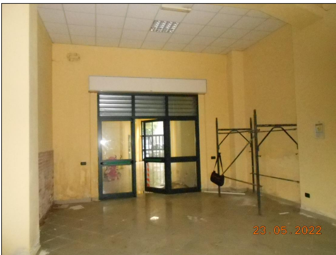
FOTO N. 12 Vista interna dei locali posteriori dell'immobile. Si notano macchie d'umidità sulle pareti.
