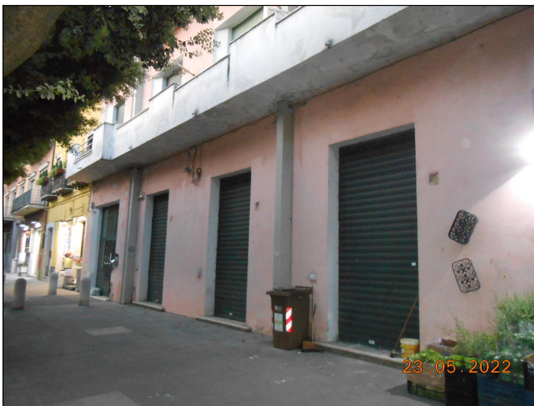
FOTO N. 02 Vista della porzione dell'immobile pignorato su viale Principe di Napoli.
