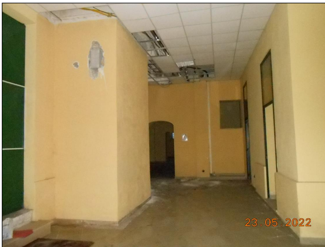
FOTO N. 38 Vista interna dell'immobile. Si notano alcuni pannelli della controsoffittatura rimossi.
