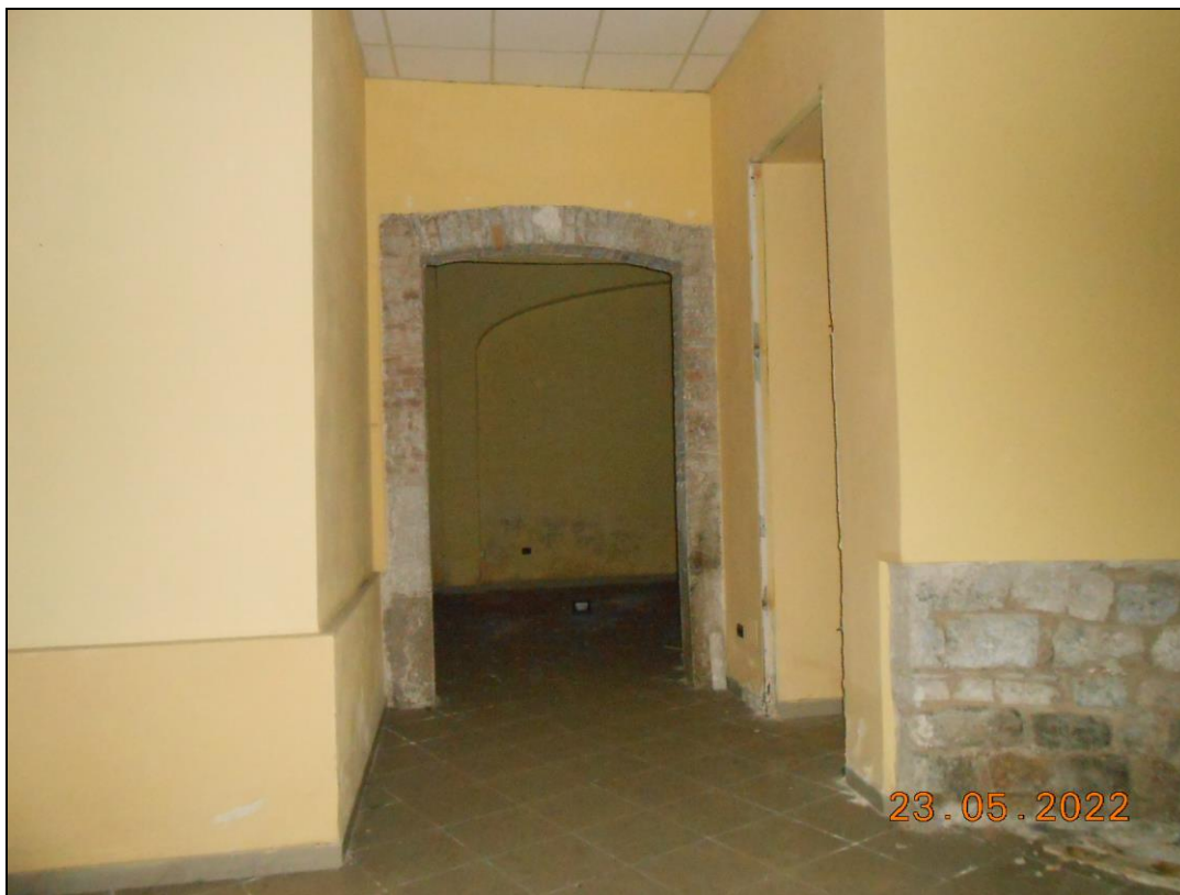
FOTO N. 39 Vista interna dell'immobile.
