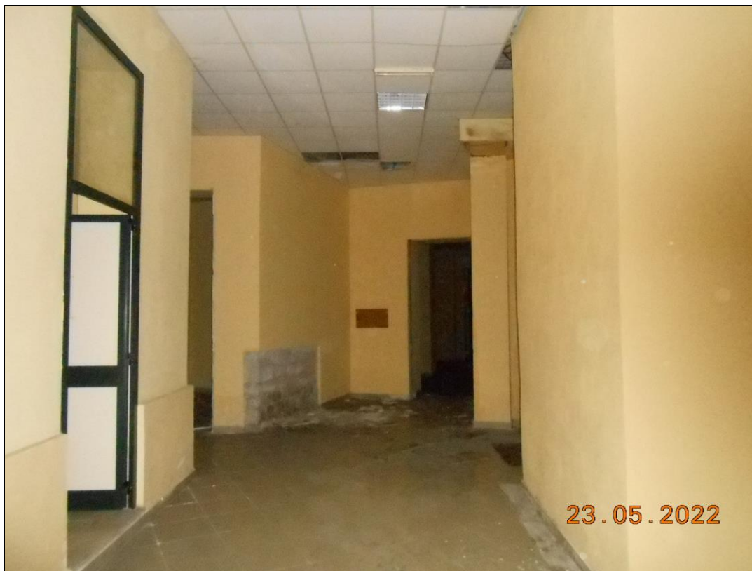
FOTO N. 31 Vista interna dei locali dell'immobile.
