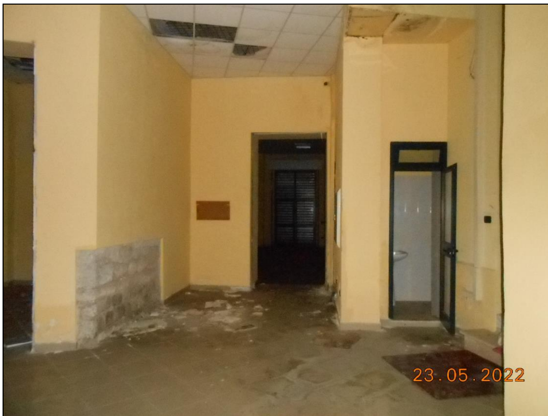
FOTO N. 35 Vista interna dei locali dell'immobile.
