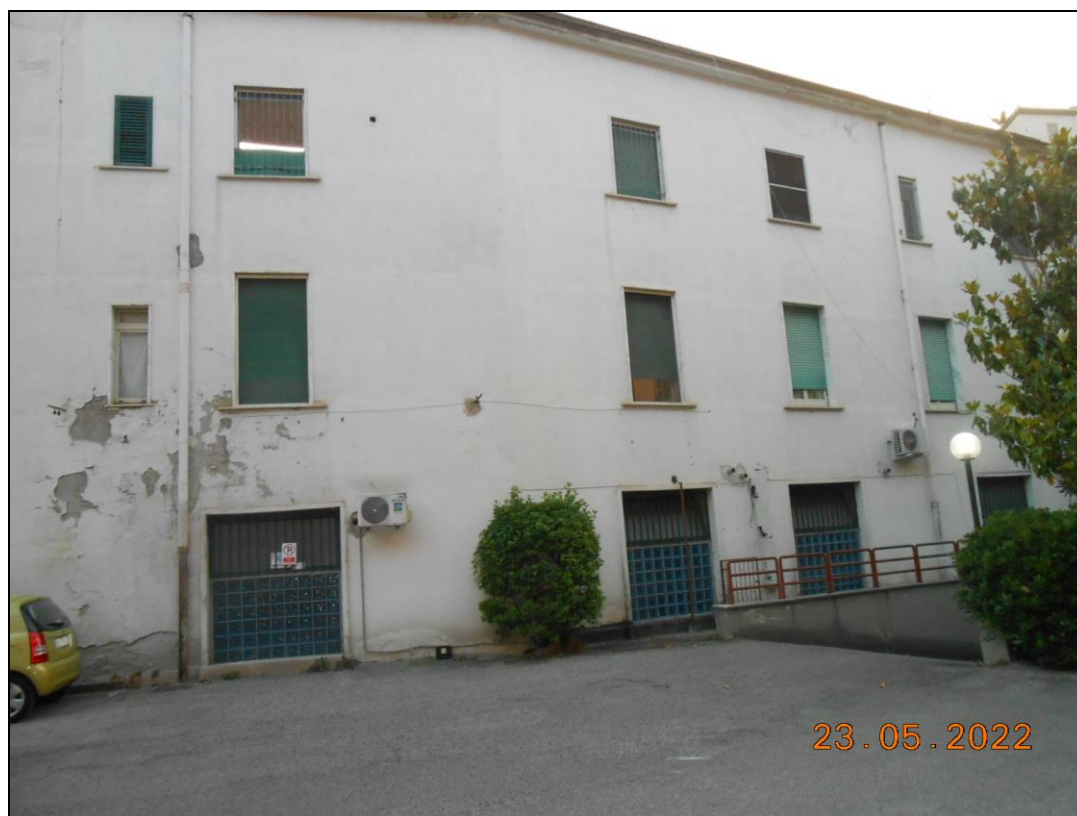
FOTO N. 52 Vista posteriore del fabbricato.
