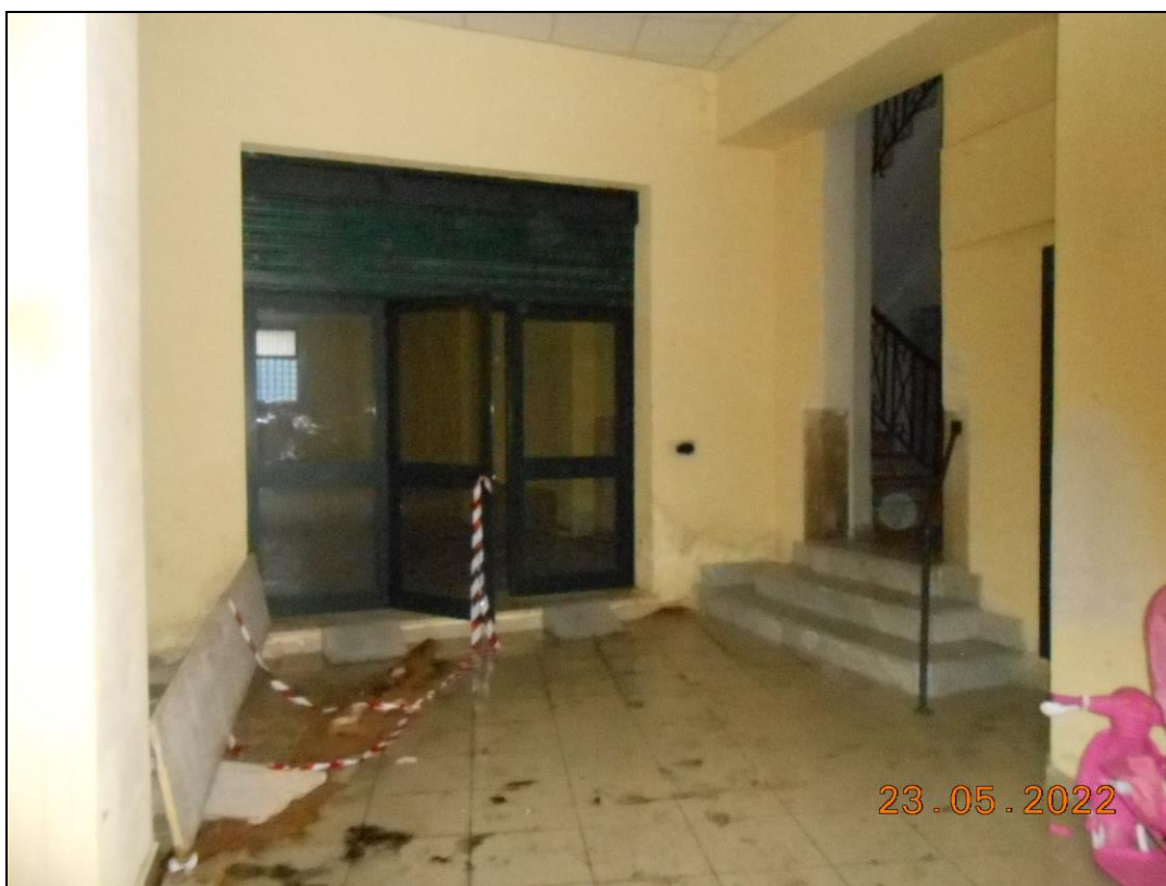
FOTO N. 10 Vista interna dell'androne. Si nota sulla destra l'accesso alla scala condominiale.
