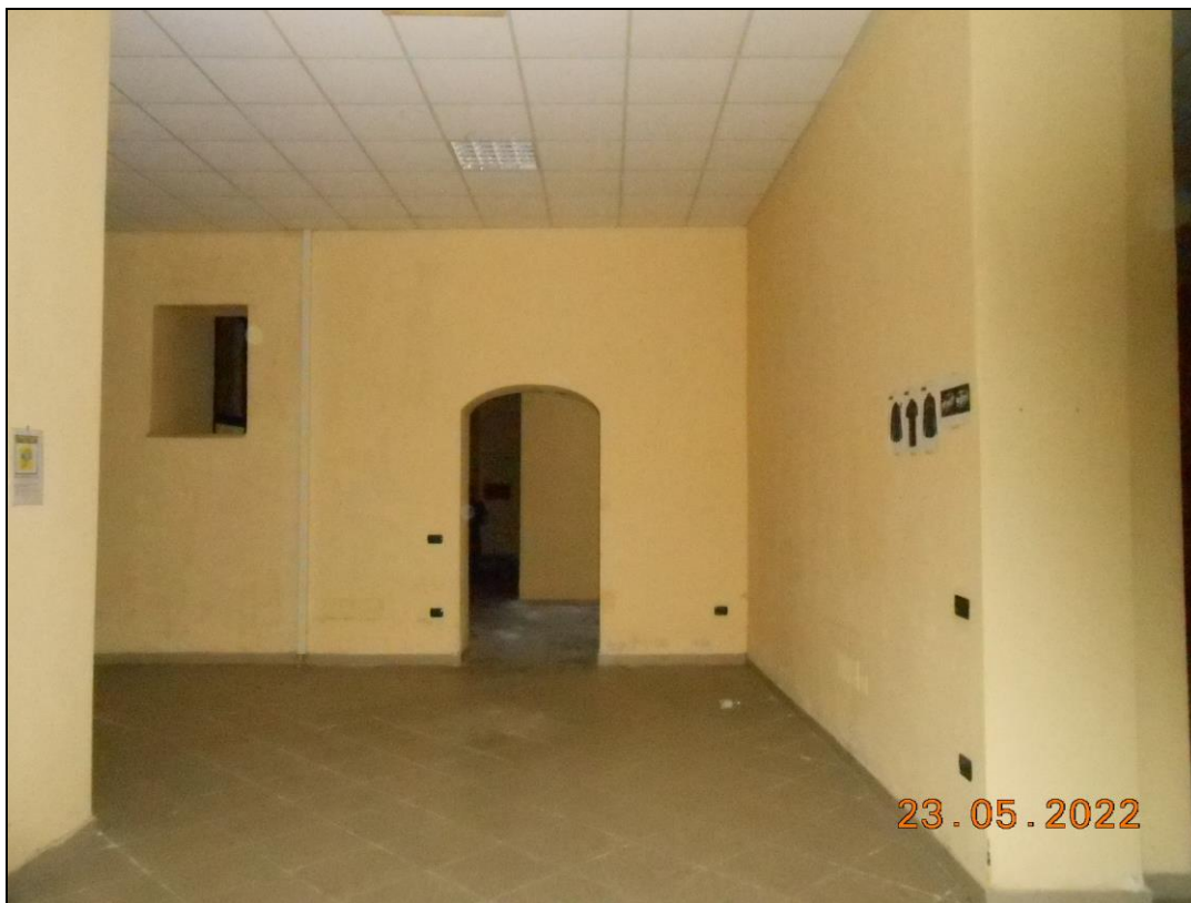
FOTO N. 17 Vista interna dei locali dell'immobile.
