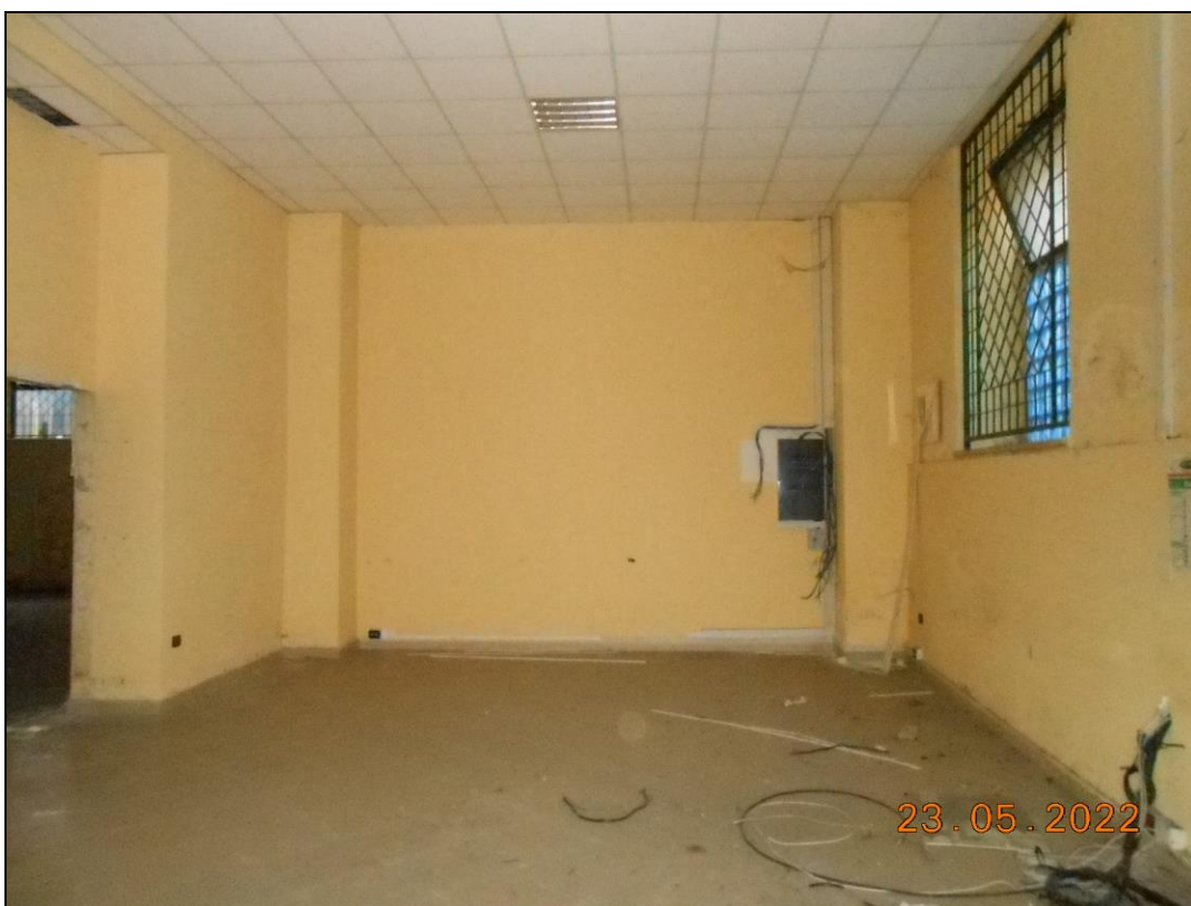
FOTO N. 22 Vista interna dei locali dell'immobile.
