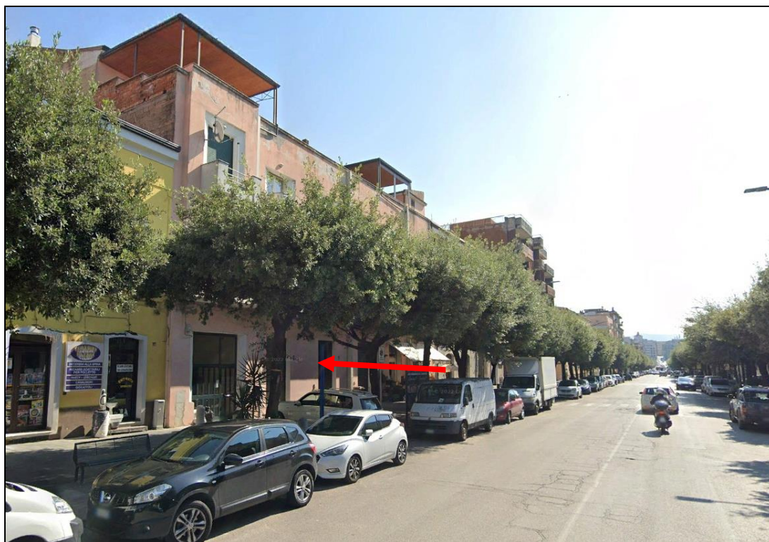
FOTO N. 04 Vista dell'immobile pignorato a piano terra del fabbricato.
