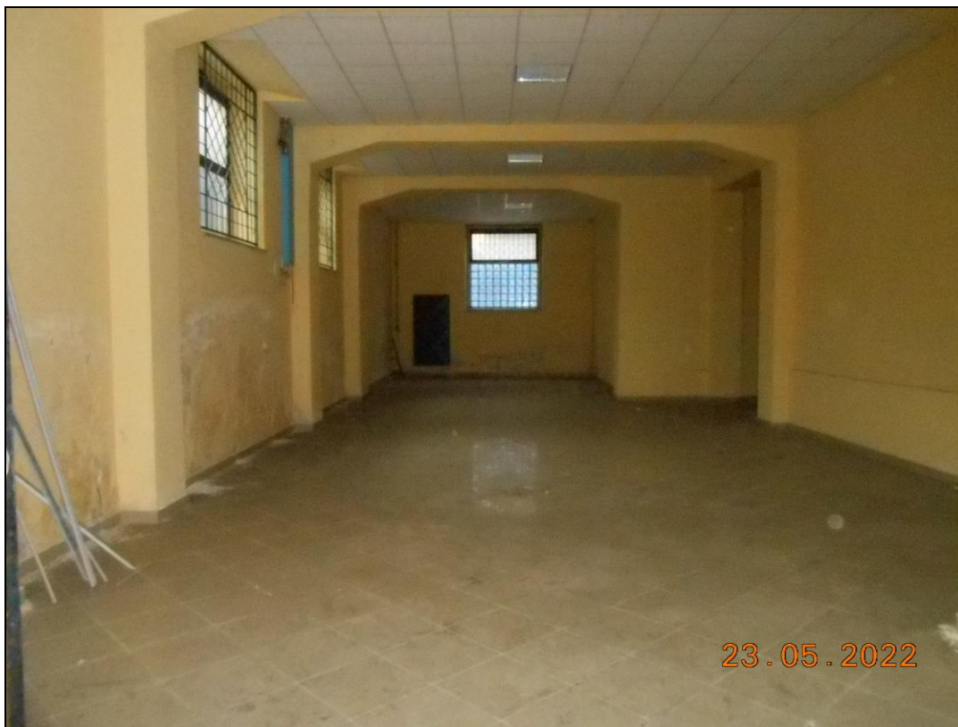
FOTO N. 13 Vista interna dei locali posteriori dell'immobile.
