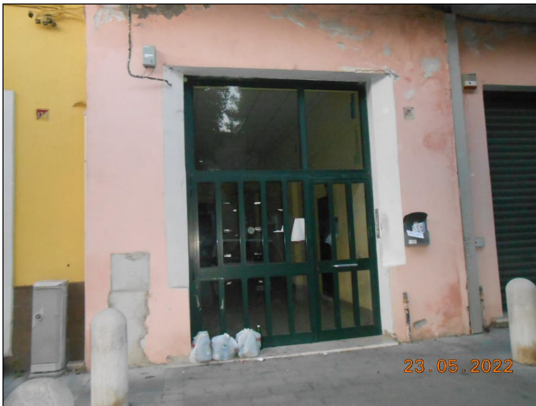
FOTO N. 03 Vista portone di accesso all'androne dell'immobile pignorato.
