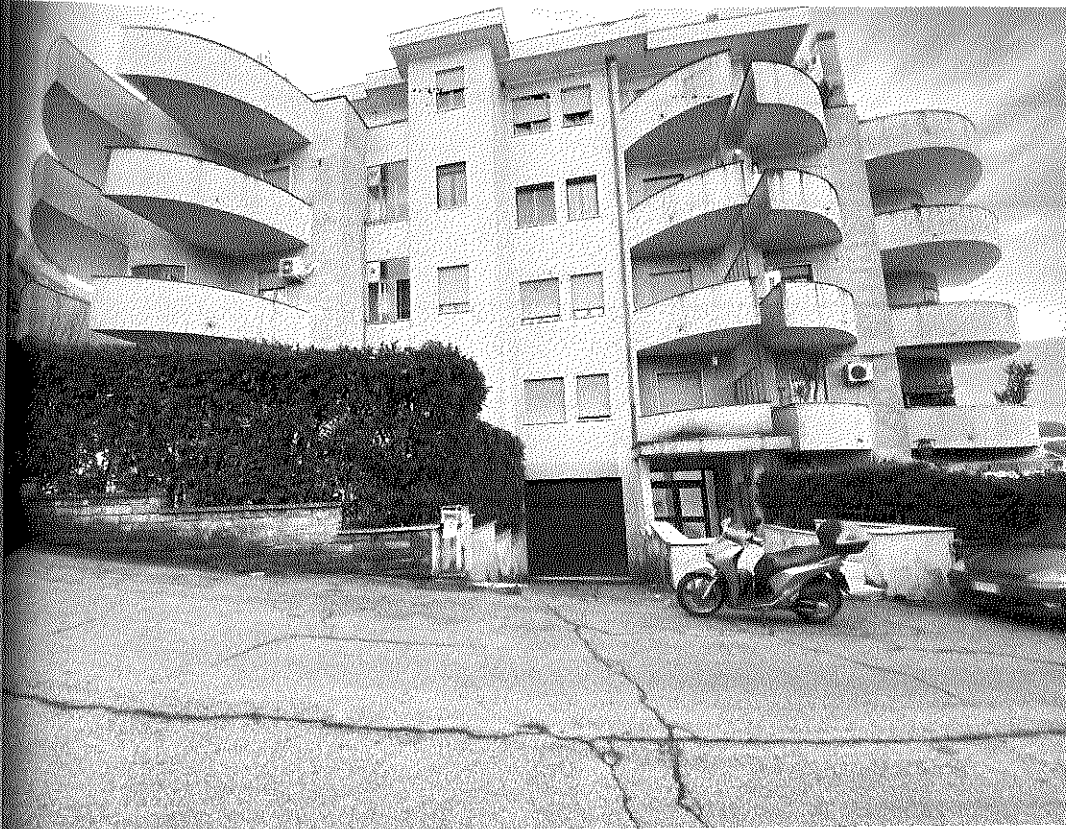
FOTO N. 3 - Vista dell'edificio da Via Pietro Metastasio dove si evidenzia la rampa che da accesso all'autorimessa dal civico 13.
