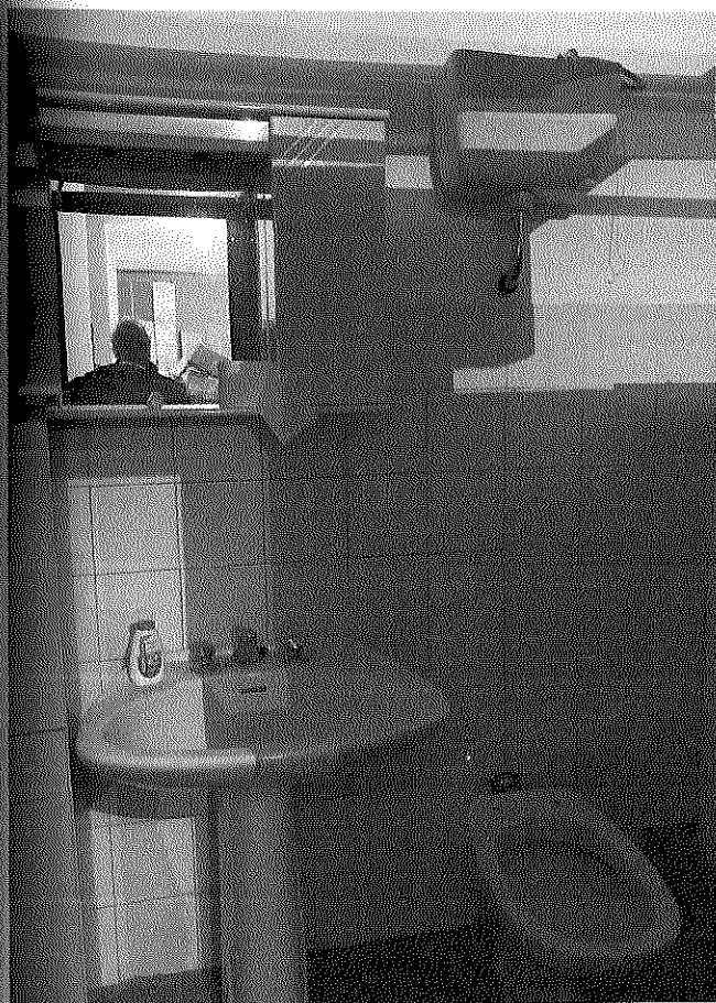
FOTO N. 9 - Vista del Bagno;
