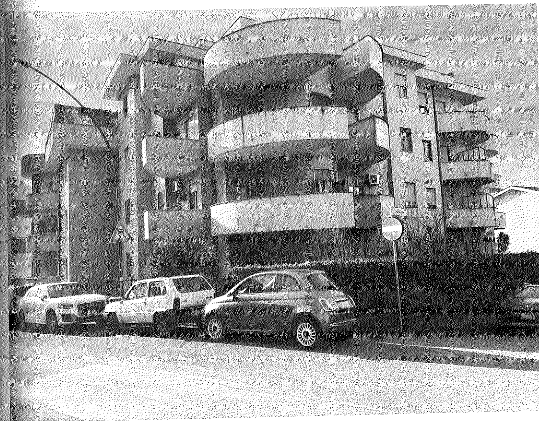
FOTO N. 2 - Vista dell'edificio angolo tra Via Dante Alighieri e Via Pietro Metastasio
