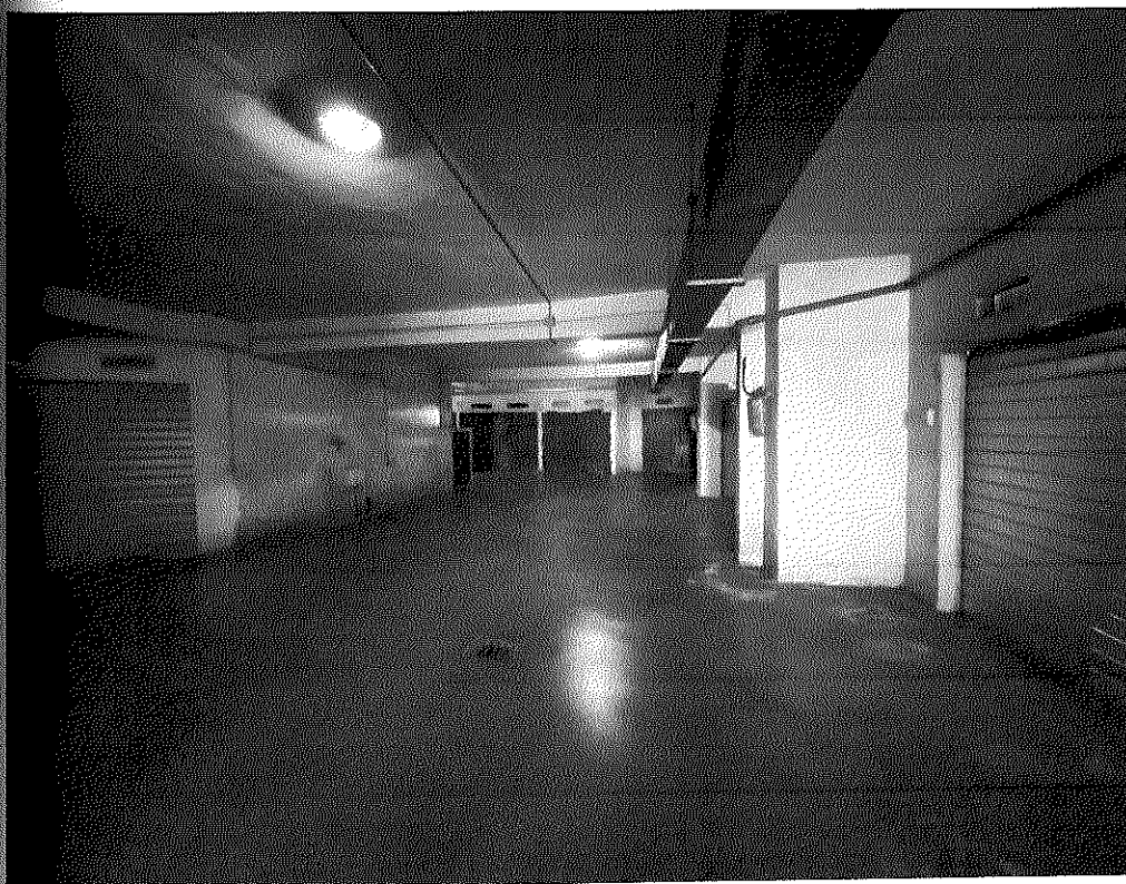
FOTO N. 13 - Vista interna dell'area di manovra che da accesso ai box
