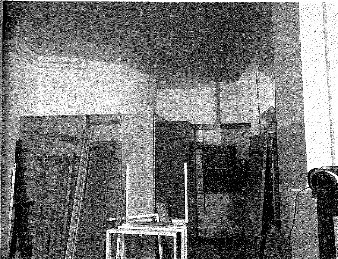
Foto n. 6 – Via interna dell'autorimessa.
