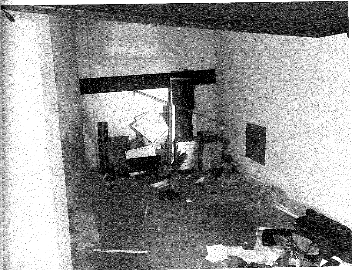
FOTO N. 16 – Vista interna del box.
