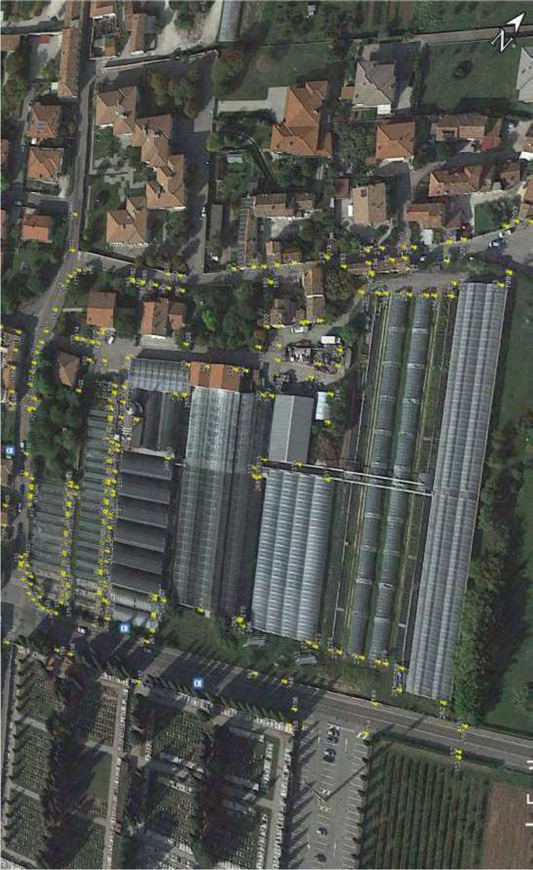
Fig. 8 – aerofotogrammetria con schema dei punti rilevati durante il sopralluogo peritale
