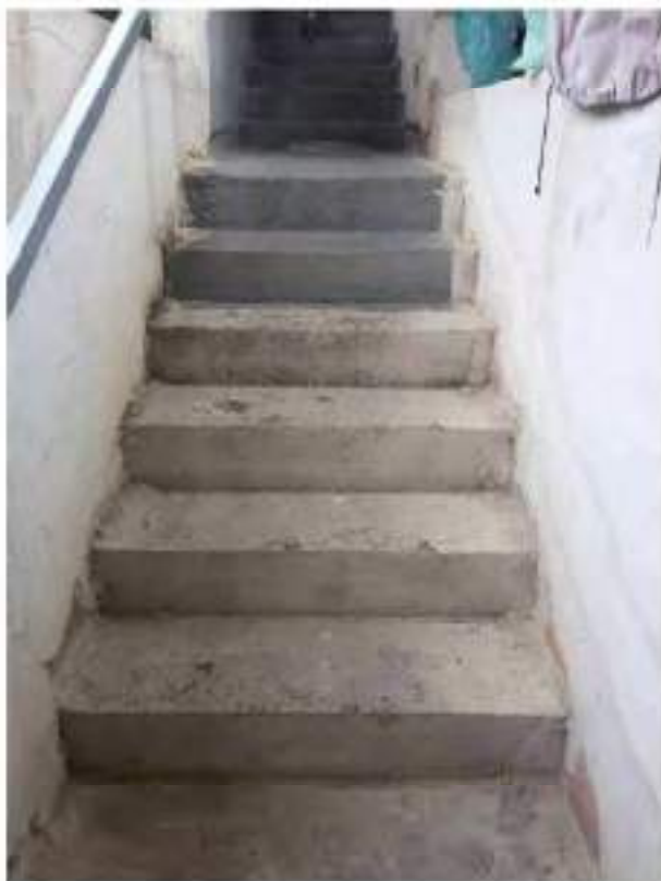
Foto n. 14 – Accesso al primo piano
