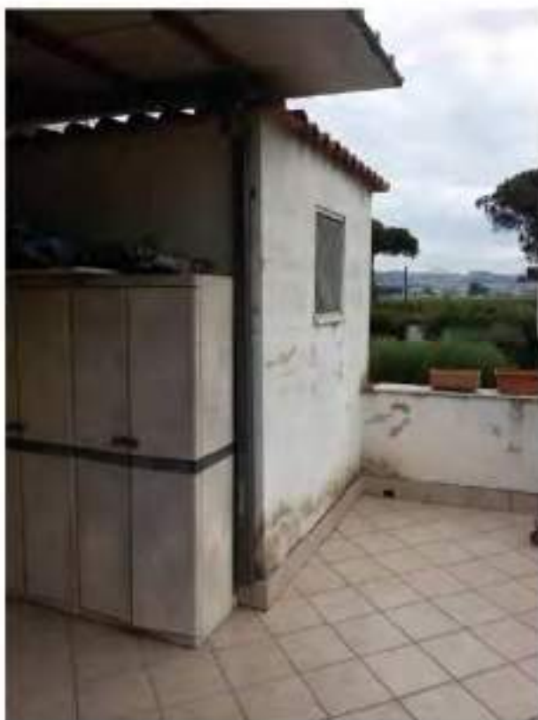
Foto n. 17 – Locale wc al primo piano
