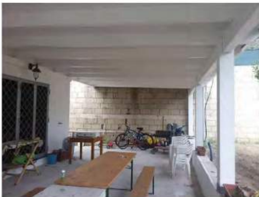
Foto n. 29 – Area esterna (NCT p.lla 139) attualmente utilizzata come corte coperta con tettoia
