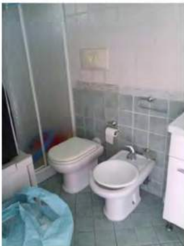
Foto n. 11 - Wc piano terra
