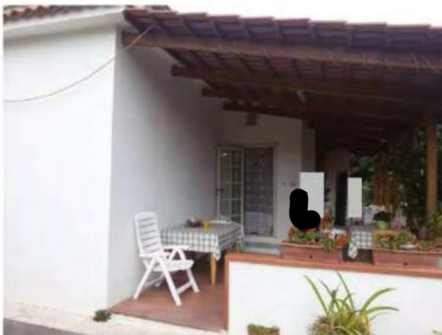
Foto n. 2 - Tettoia lato est ed ingresso all'appartamento
