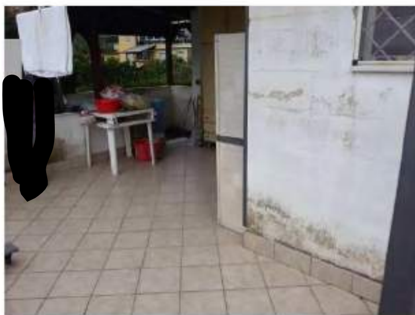
Foto n. 18 – Terrazzo al primo piano
