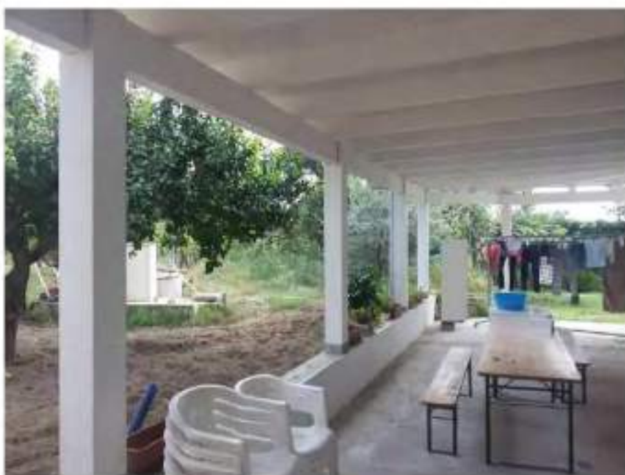
Foto n. 30 – Area esterna (NCT p.lla 139) attualmente utilizzata come corte coperta con tettoia
