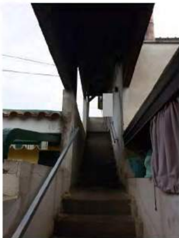
Foto n. 15 – Accesso al primo piano
