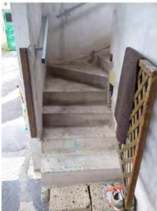
Foto n. 13 – Accesso al primo piano
