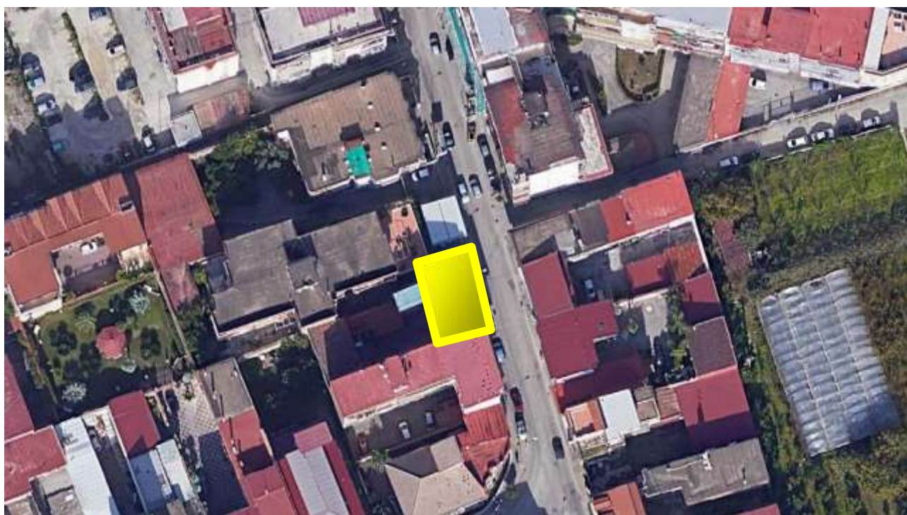
Figura 2 - Inquadramento planimetrico edificio di cui fa parte l'edificio oggetto di consulenza Via Matteotti, 36 in Grumo Nevano (Na)
