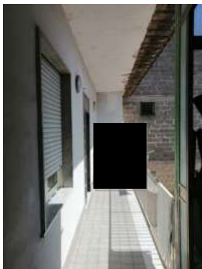
Foto n. 14 – Ballatoio lato interno
