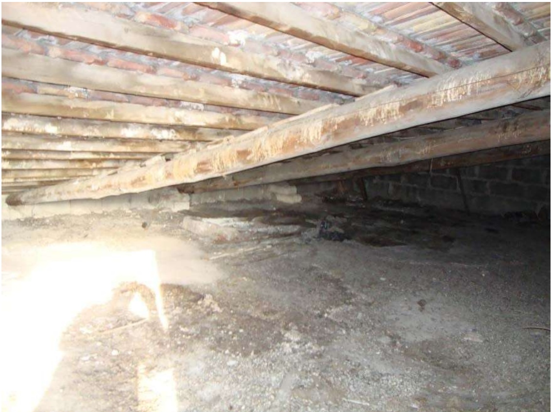
Foto n. 8 - Sottotetto non abitabile e copertura
