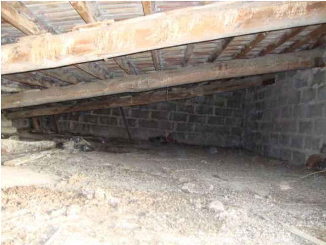
Foto n. 7 – Sottotetto non abitabile e copertura
