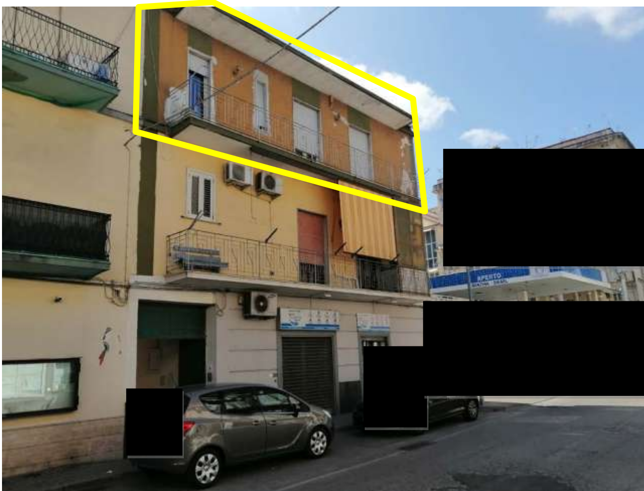
Foto n. 1 - Prospetto principale esterno del fabbricato ingresso su via Matteotti, 36. Lato esterno appartamento oggetto di divisione posto al secondo piano (campitura in giallo)
