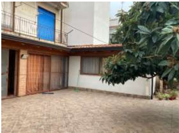
Foto 40 “Prospetto su corte interna – vista 3”
