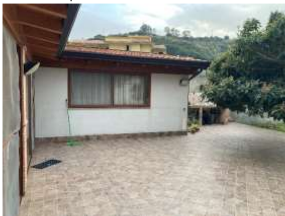
Foto 43 “Prospetto su corte interna – vista 6”
