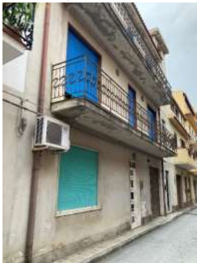
Foto 2 “Prospetto su via G. Pino – vista 2”
