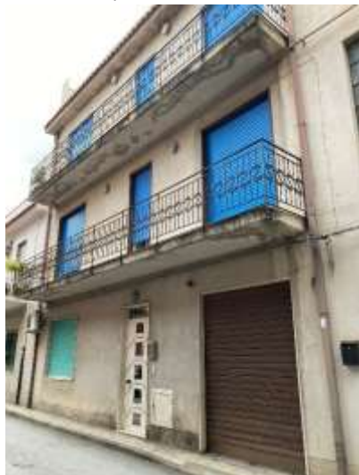
Foto 1 “Prospetto su via G. Pino – vista 1”
