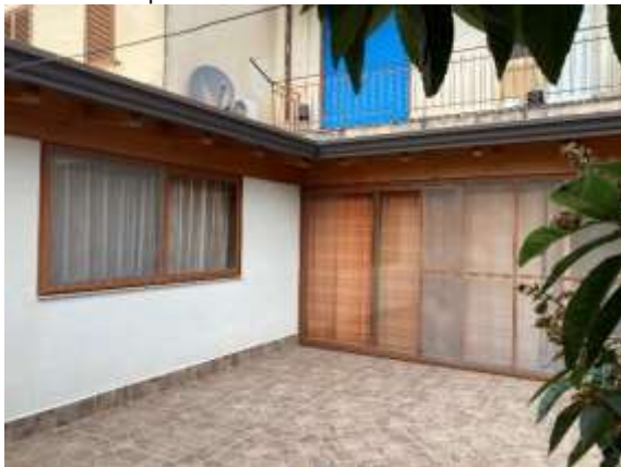
Foto 39 “Prospetto su corte interna – vista 1”
