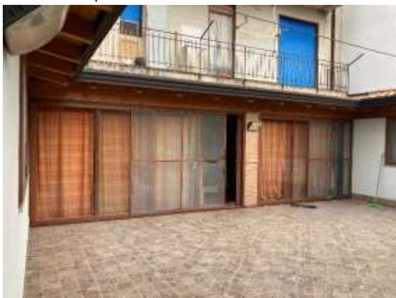
Foto 38 “Prospetto su corte interna – vista 1”
