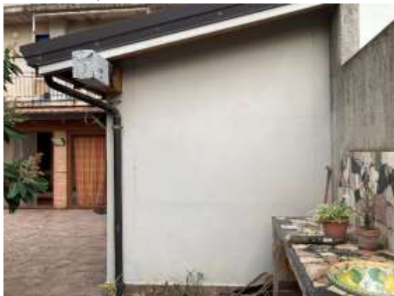
Foto 41 “Prospetto su corte interna – vista 4”
