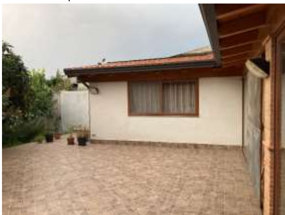
Foto 42 “Prospetto su corte interna – vista 5”
