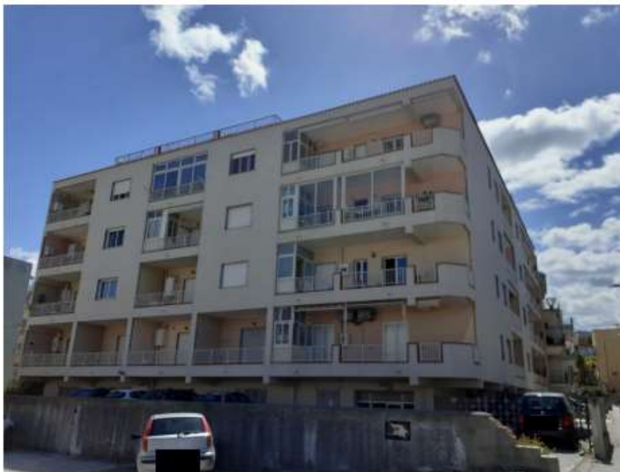
Foto nr. 1 : fabbricato ove è ubicato l'immobile oggetto della presente
