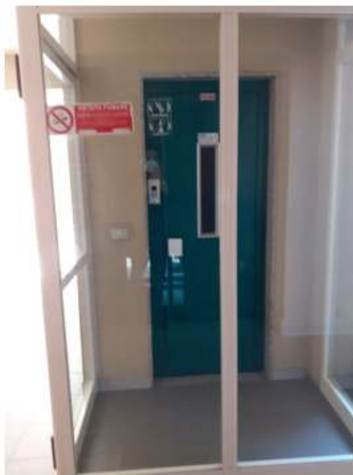
Foto nr. 2 : particolare del corpo ascensore
