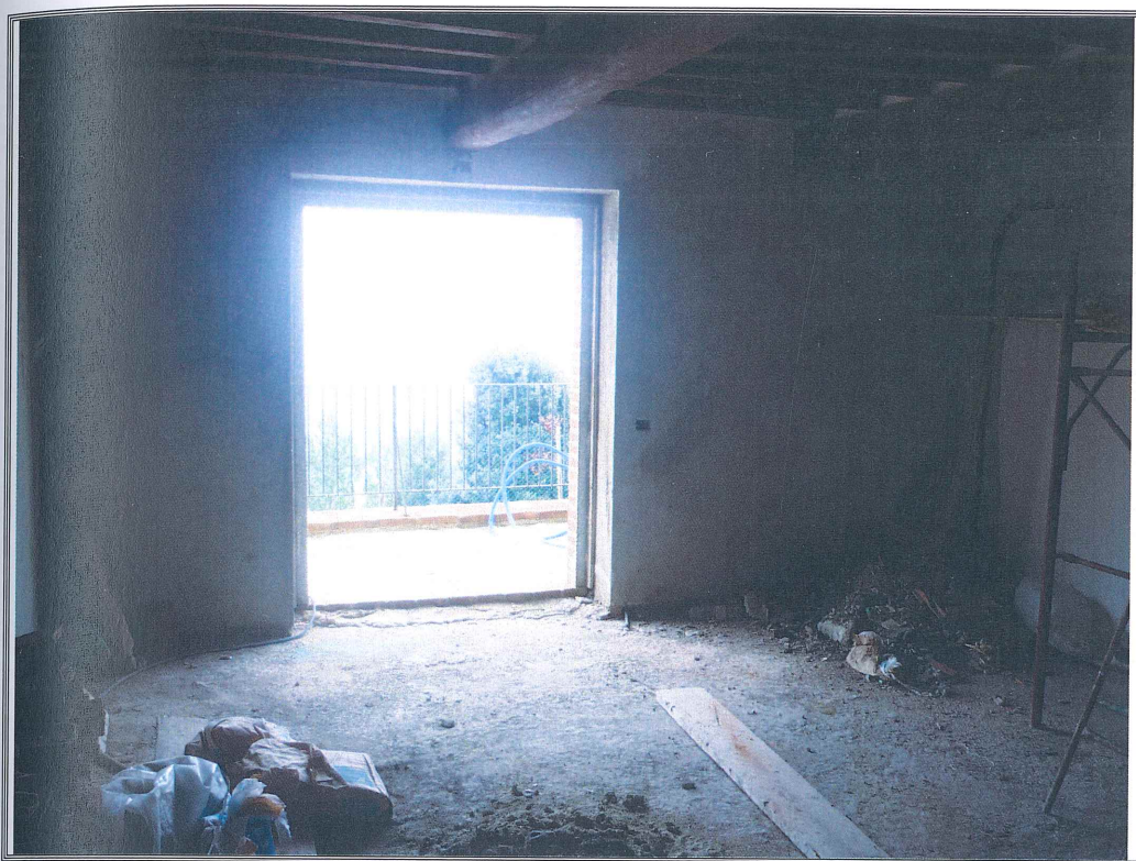
Foto n. 43 Lotto n. 7 - vista dello stato dei lavori degli interni.
