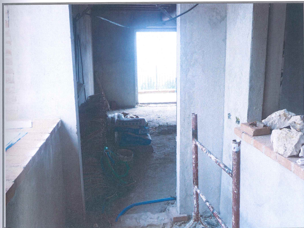
Foto n. 42 Lotto n. 7 - ingresso all'unità abitativa in corso di ultimazione.
