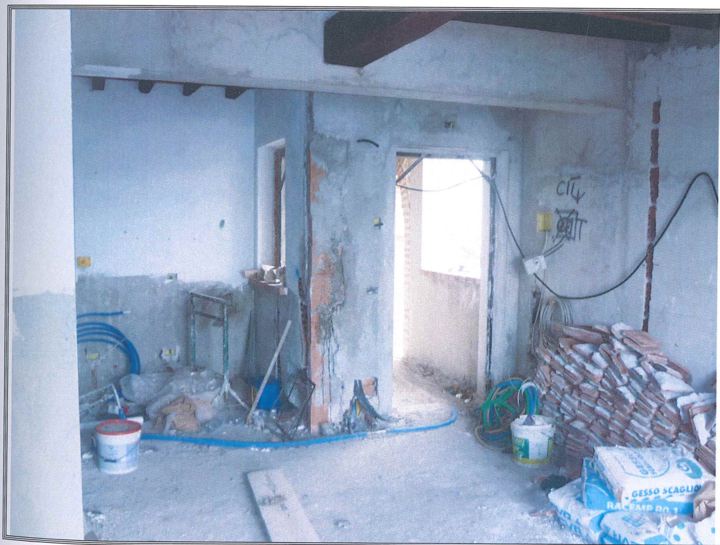
Foto n. 44 Lotto n. 7 - vista dello stato dei lavori degli interni.
