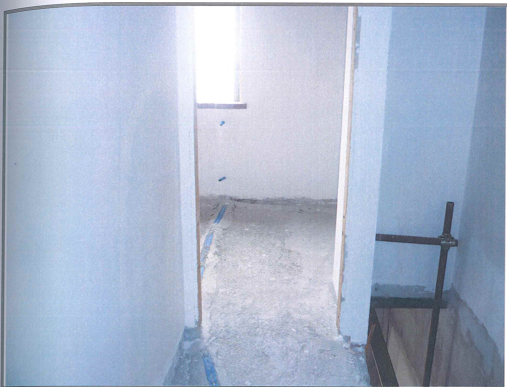
Foto n. 45 Lotto n. 7 – vista dello stato dei lavori degli interni.
