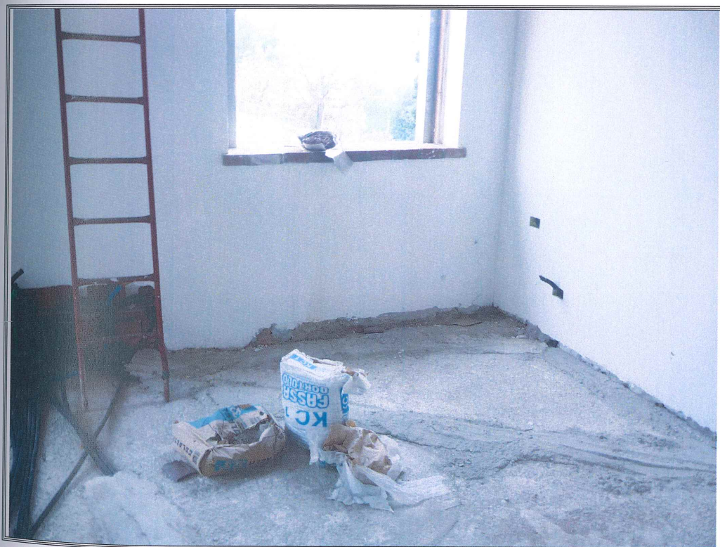
Foto n. 46 Lotto n. 7 – vista dello stato dei lavori degli interni.
