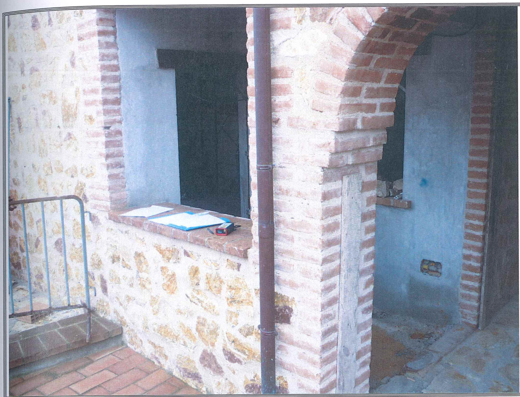
Foto n. 41 Lotto n. 7 - ingresso all'unità abitativa in corso di ultimazione.
