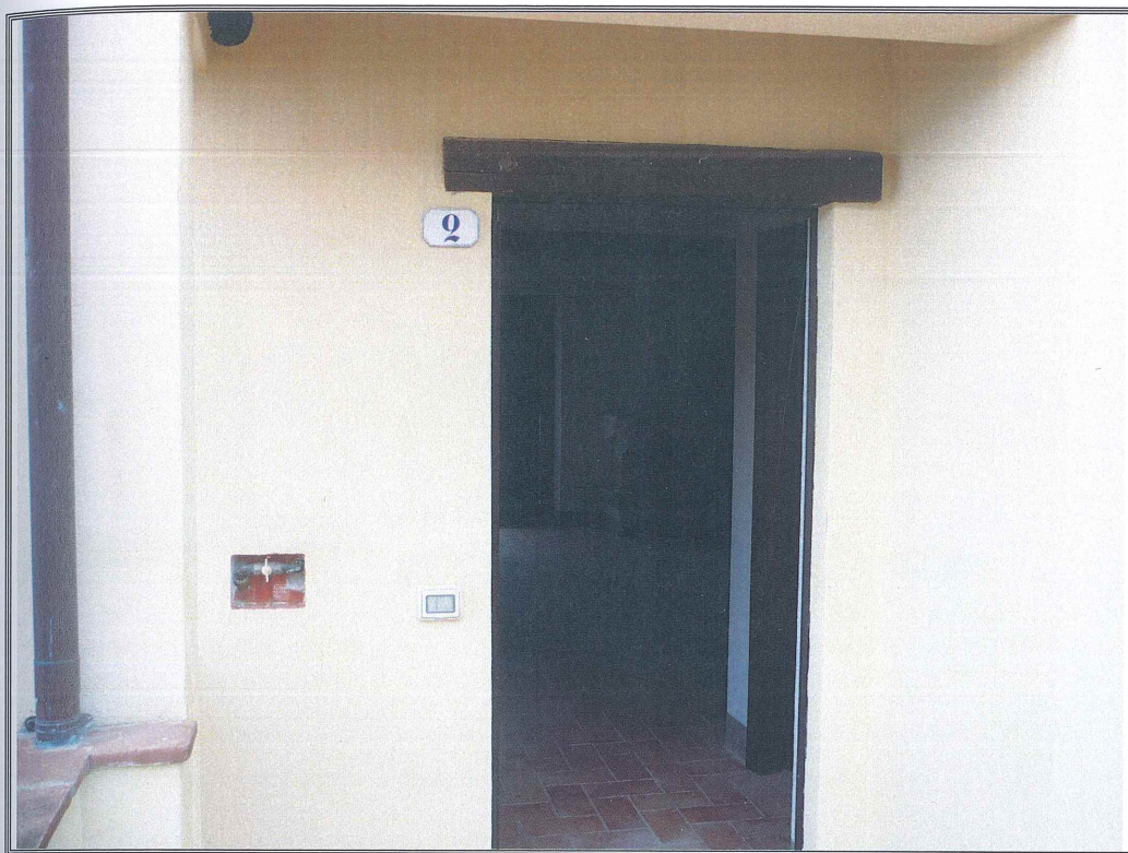
Foto n. 11 Lotto n. 1 – porta di ingresso all'unità immobiliare.
