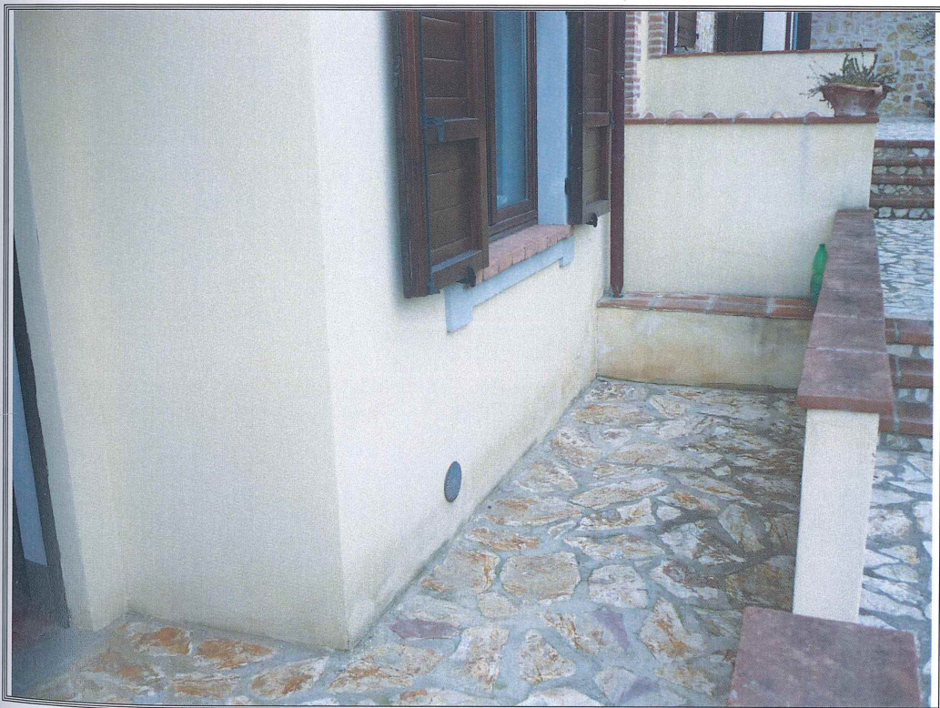
Foto n. 12 Lotto n. 1 – corte esterna lastricata.
