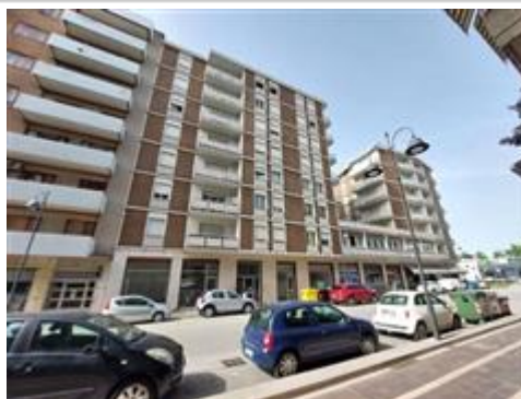
Panoramica edificio condominiale
